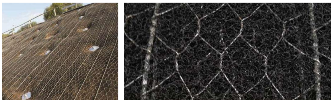
Figura 10 - Geostuoia rinforzata in rete metallica tipo MacMat Hs
