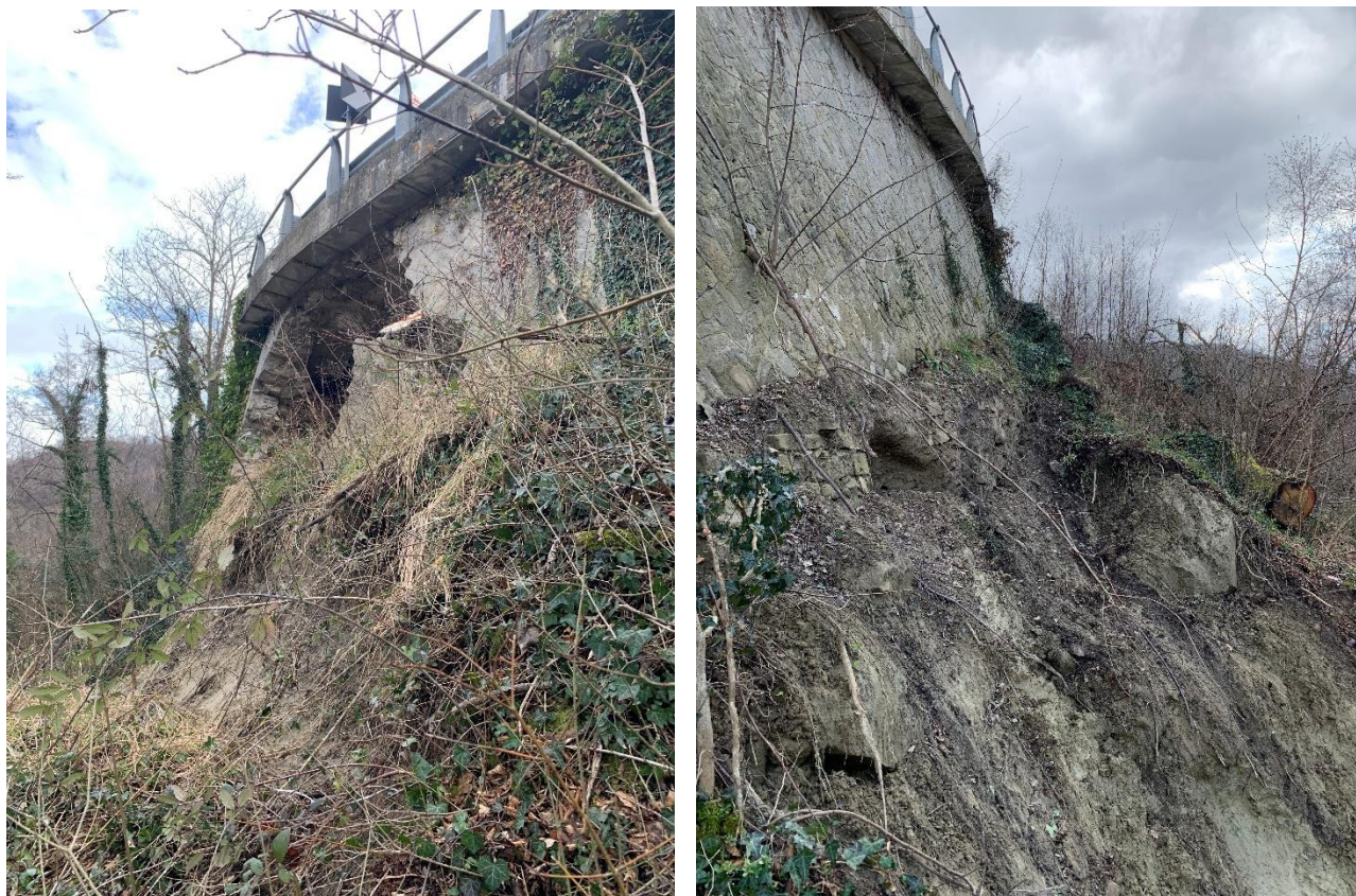
Figura 6 - Stato dei luoghi nell'area oggetto di intervento
