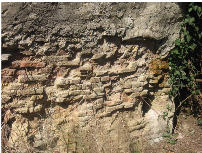
Fotografia 11: Porzioni di muratura mancante alla base della pila sinistra
