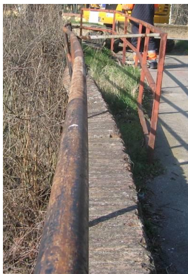
Fotografia 13: Collasso del muretto laterale e del parapetto
