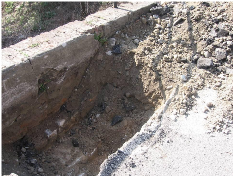
Fotografia 5: Saggio in chiave alla campata centrale
