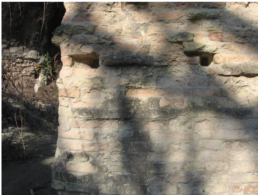
Fotografia 12: Porzioni di muratura mancante alla base della pila destra
