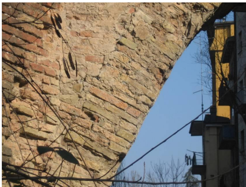
Fotografia 8: Polverizzazione alle reni dell'arcata destra
