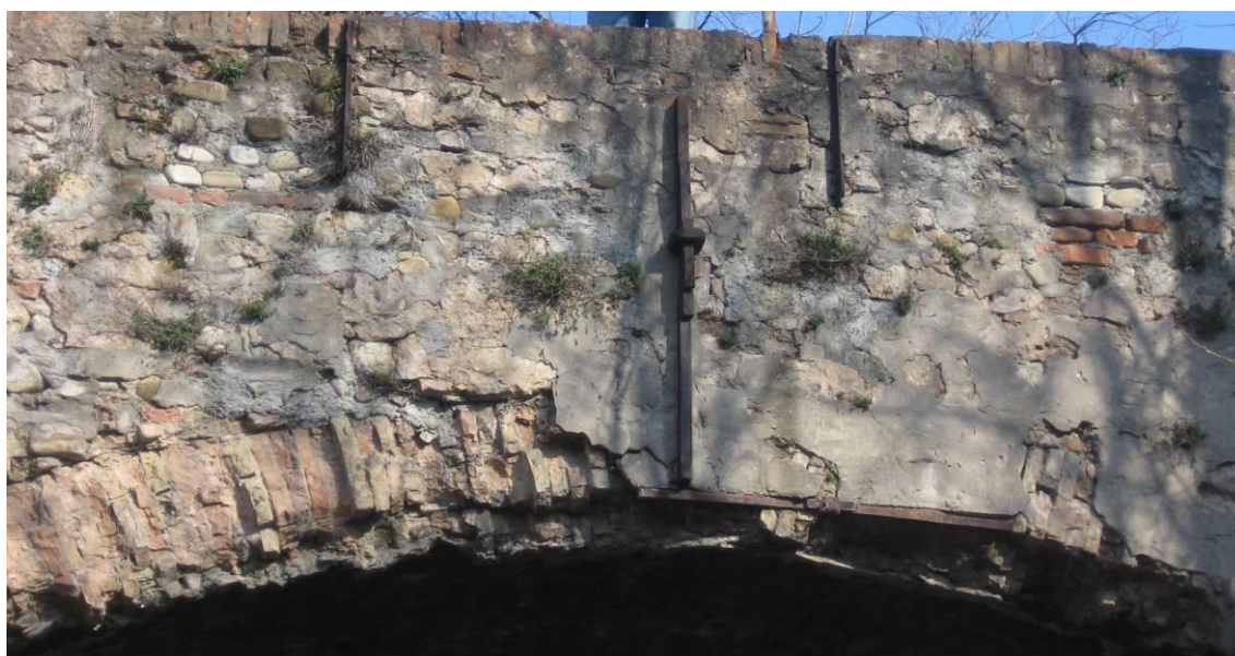
Fotografia 9: Polverizzazione in chiave arcata centrale
