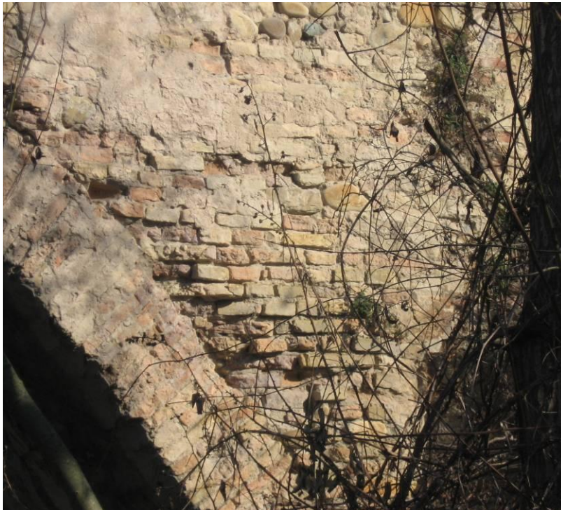
Fotografia 10: Disgregazione alla base della pila destra
