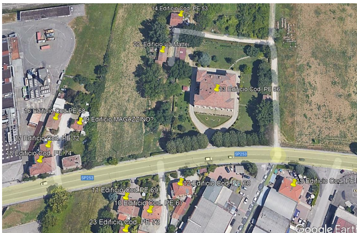
Figura -11 Edifici oggetto di monitoraggio in corrispondenza delle Pile 3, 4, 5 e 6 e della Spalla B da Google Earth®
