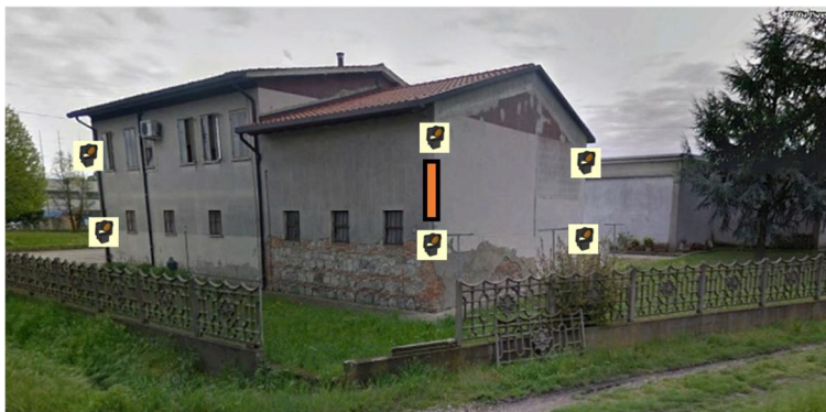
Figura -16 - Schema sintetico a titolo esemplificativo del posizionamento dei sensori per il monitoraggio topografico (mire topografiche) e delle rotazioni (clinometri)
