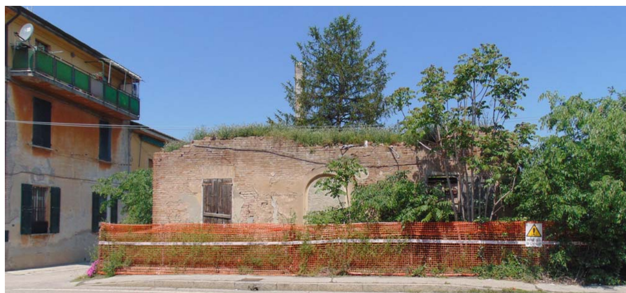
Fotografia lato nord, foto di maggio 2022
