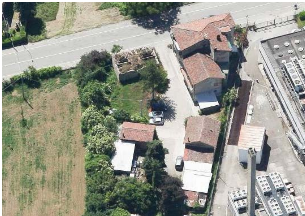
Vista aerea lato sud, foto del 2021 dopo il crollo (fonte Sit bologna)
