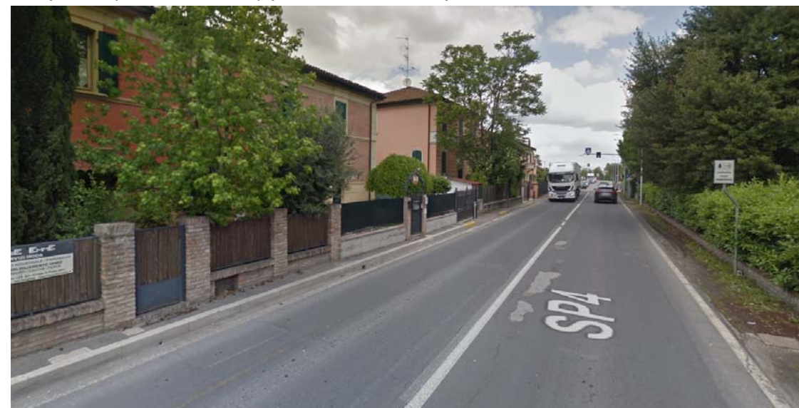
Figura 2-10 – Attraversamento urbano SP 4 Galliera – via Beretta – stato attuale
