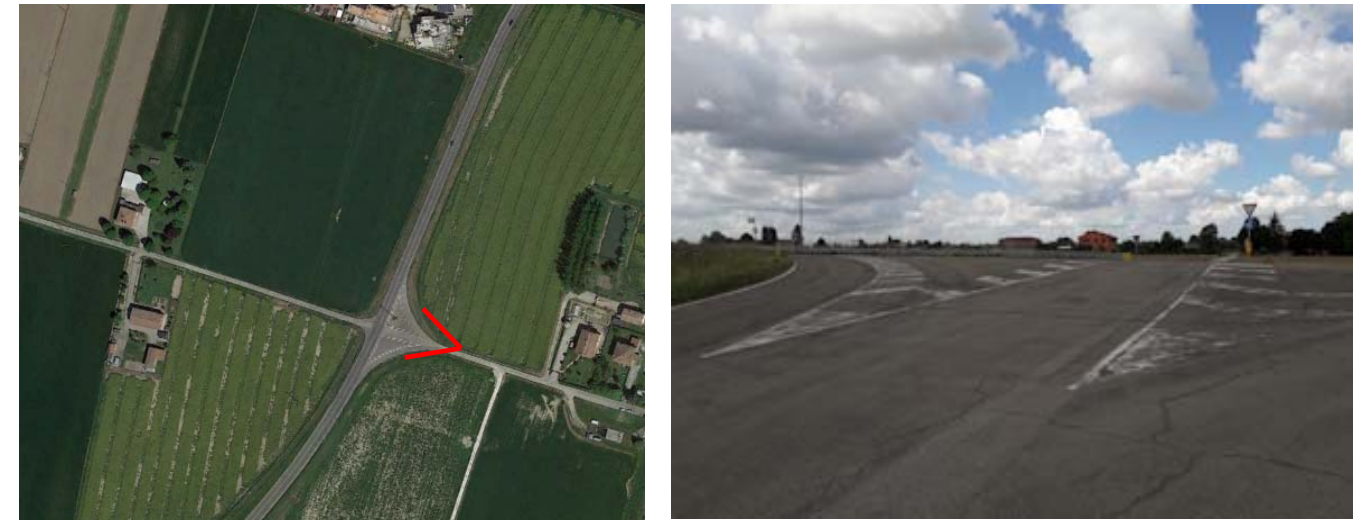
Figura 4-22. Vista dell'intersezione oggetto di intervento n. 1
