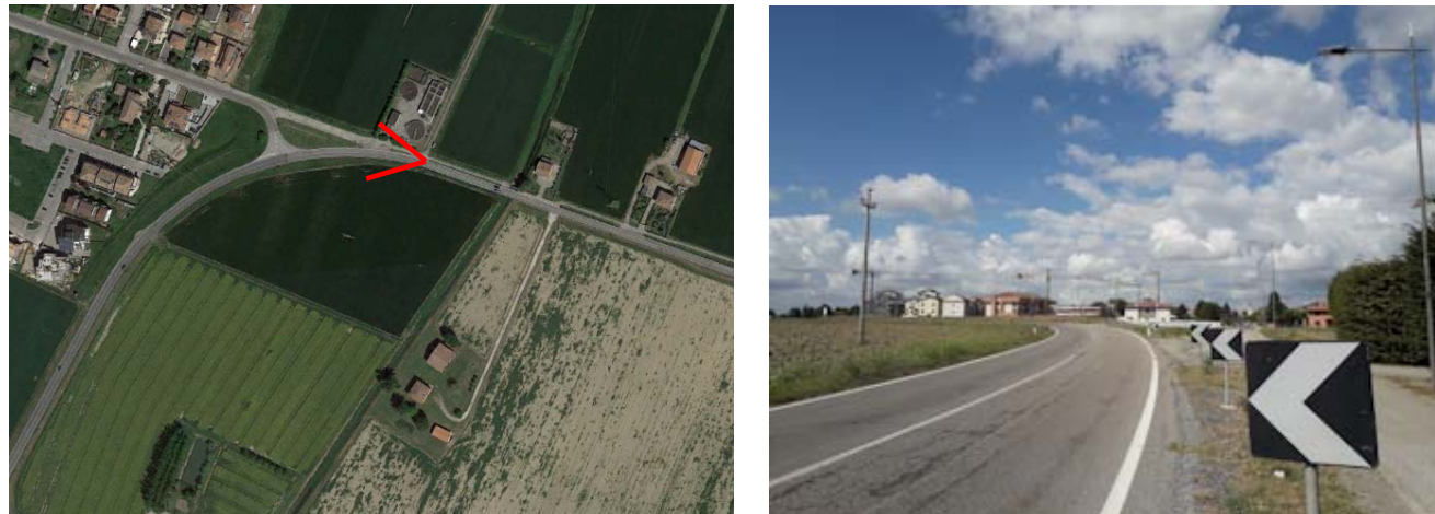
Figura 4-30. Vista dell'intersezione oggetto di intervento n. 5
