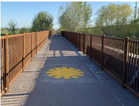
Figura 37. Esempio di segnaletica orizzontale con logo della Ciclovía del Sole realizzata
