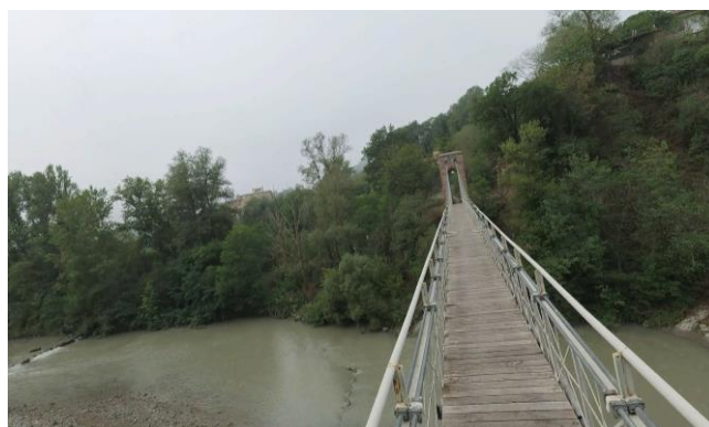
Ponte delle Streghe
