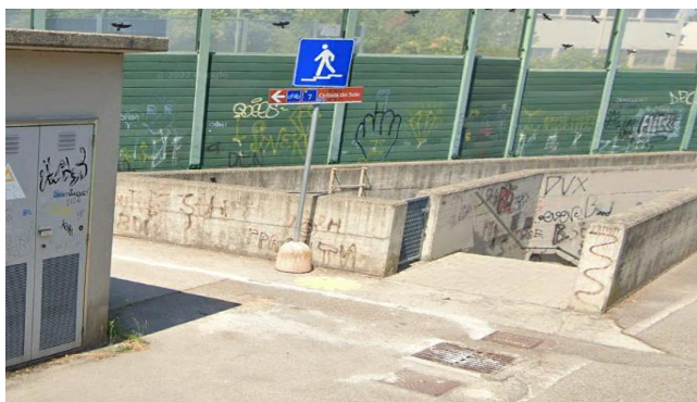
Scalinata in corrispondenza di via Cento
