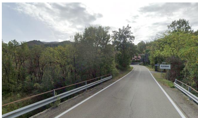
Itinerario lungo la SP23, ingresso località Suviana
