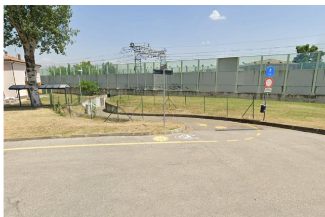
Ciclabile esistente in uscita dal sottopasso ferroviario
