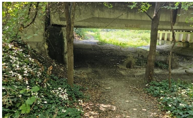
Foto del sottopasso in destra idraulica
