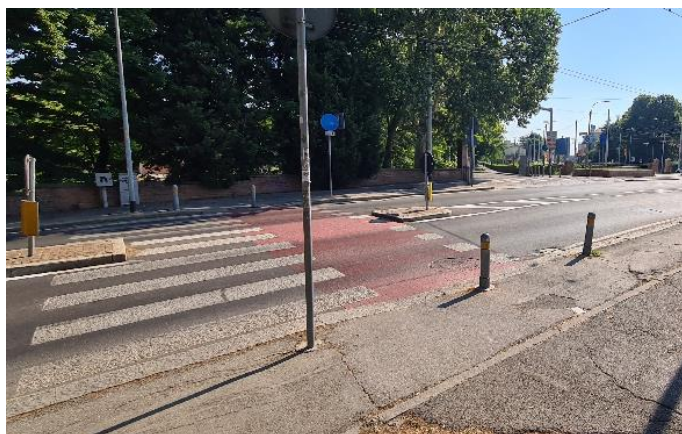
Foto attraversamento via della Barca
