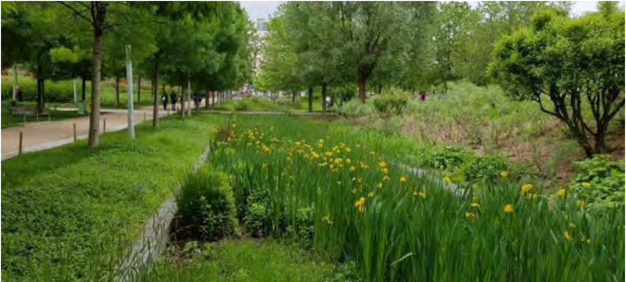
FIGURA 6.2.2 - ESEMPIO DI NOUE PAYSÀÈRE CON SEZIONE STRUTTURATA DA ELEMENTI MINERALI DI BORDO E VEGETAZIONE, PARCO MARTIN LUTHER KING A PARIGI, ATELIER JACQUELINE OSTY).
