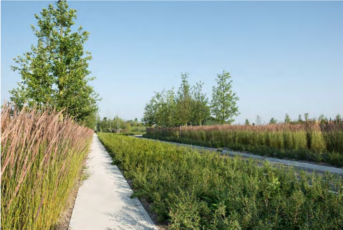
Figura 5.6.3.4 - Esempio di Rain garden applicato a strade e percorsi ciclopedonali: Calvados-Honfleur Business Park (Francia) – La Compagnie du Paysage
