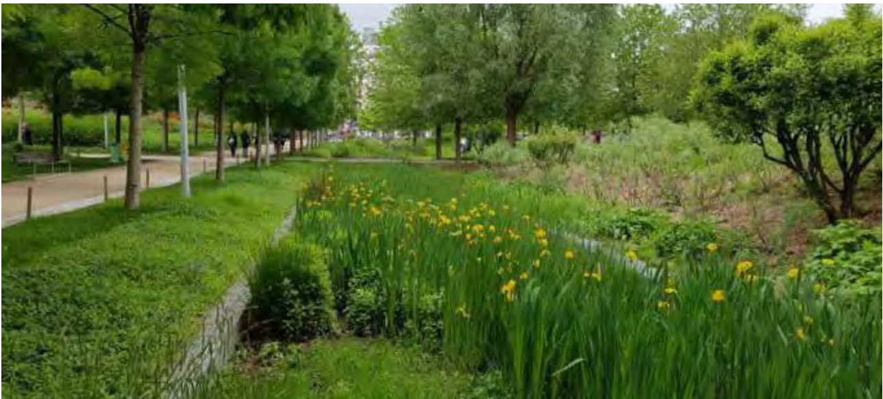
Figura 5.6.3.2 - Esempio di noue paysaère con sezione strutturata da elementi minerali di bordo e vegetazione, Parco Martin Luther King a Parigi, Atelier Jacqueline Osty)
