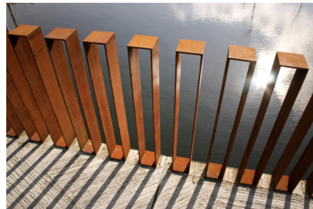
Parapetto in Corten
