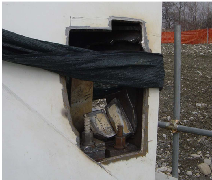
Esempio di apertura temporanea sul fianco del cassone del cassone per serraggio tirafondi
