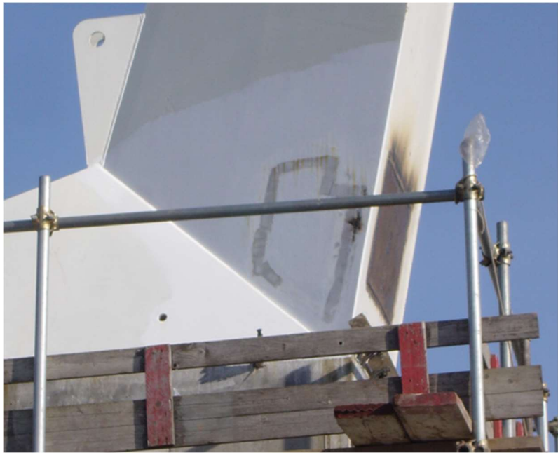
Immagine che mostra la successiva chiusura delle aperture temporanee
