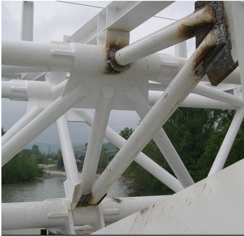
Esempio di nodo tra aste circolari con fazzoletti saldati
