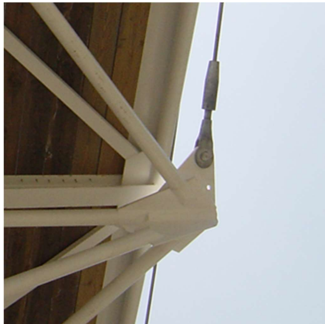
Esempio di nodo tra aste circolari e strallo
