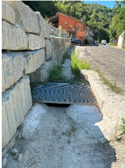
Figura 6-1: Cunette di scolo nel pozzetto esistente nel sito di Vado (2)
