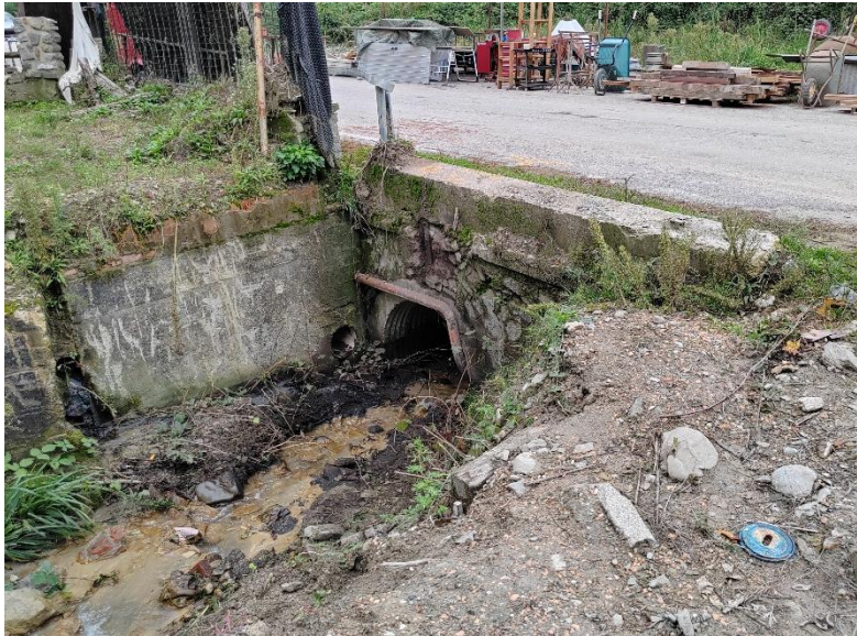
Figura 3-2: Imbocco attraversamento idraulico della SP325 del Rio Ancini post eventi alluvionali del 2023/24
