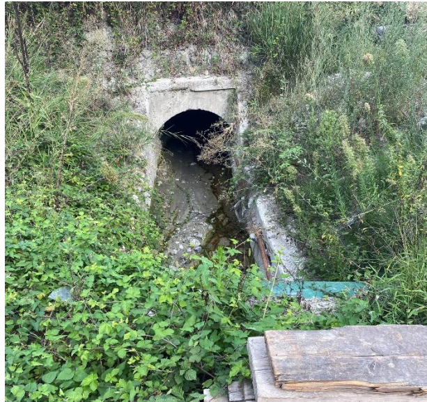
Figura 3-4: Imbocco attuale dell'attraversamento idraulico del rilevato autostradale del Rio Ancini
