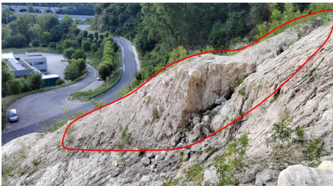
Figura 7-31. Porzioni di coltre rimasta in posto e non rimossa dalla pulizia eseguita con escavatori successivamente agli eventi del maggio 2023. Coincide con l'area denominata "M_007" di Figura 7-32.
