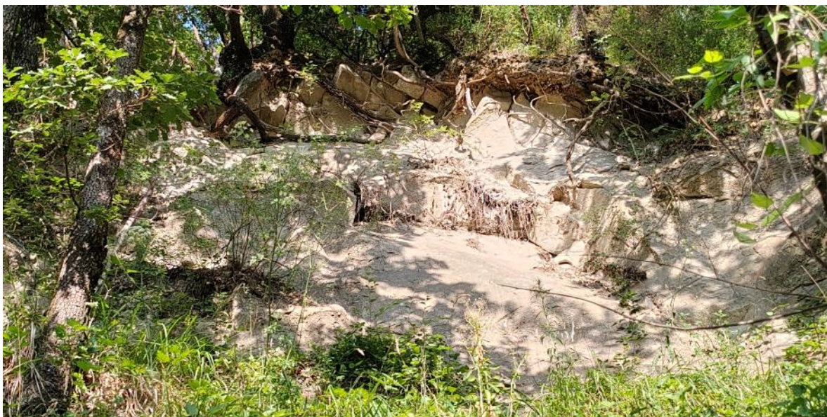
Figura 7-43. Ripresa dal basso del fronte roccioso ricadente all'interno dell'area denominata M_012. Si noti la presenza di discontinuità subverticali, talvolta pervasive, l'aumento della fratturazione nei pressi del ciglio, dovuto al maggiore detensionamento e dell'apertura dei giunti imputabile, tra gli altri, alla crescita di apparati radicali. Si riconoscono anche nicchie di distacco fresche.
