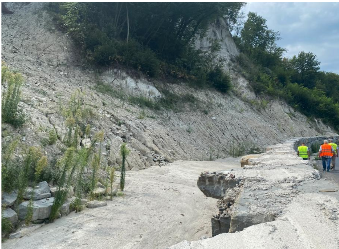
Figura 3-15. Porzione meridionale della tratta stradale attenzionata relativa al sito di Vado (1) ripresa lateralmente dal nord-est.
