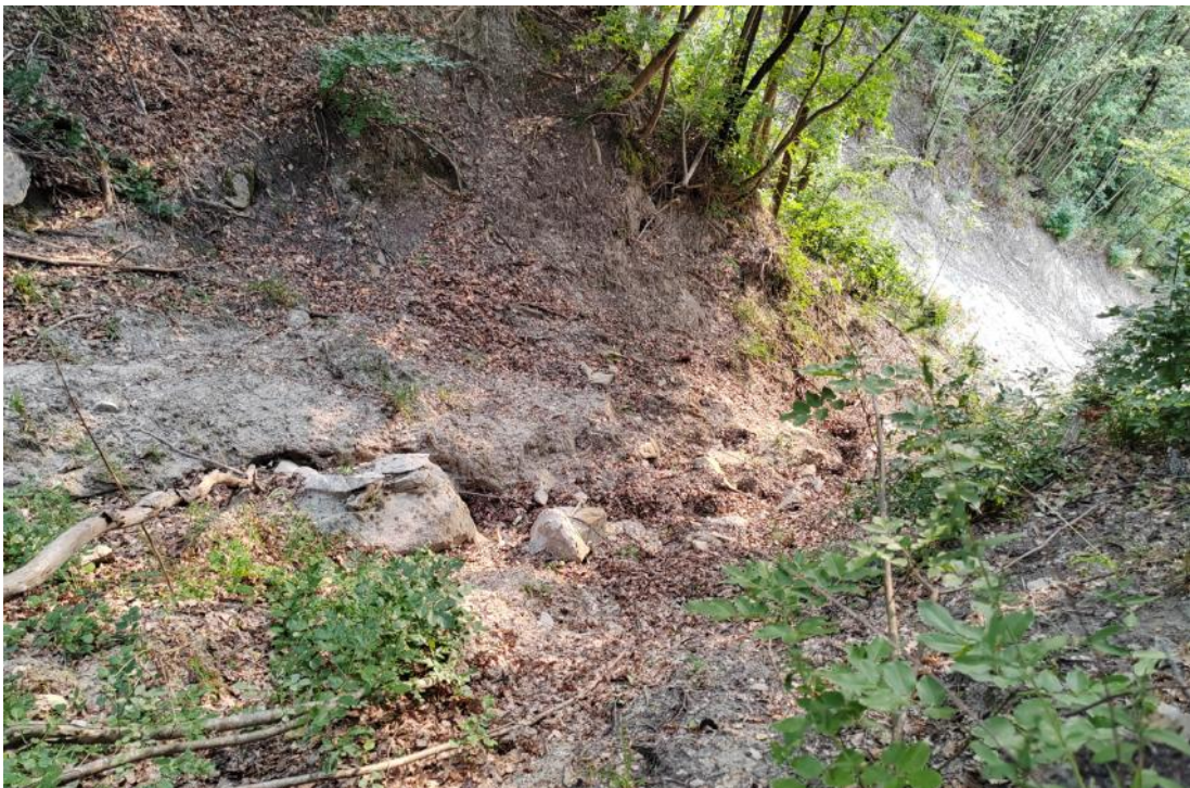
Figura 7-39. Vista dall'alto dello sbocco del canale che ospita presso l'area denominata M_006 verso la scarpata riprofilata sottostante. Si noti il salto morfologico ed il solco lungo il detrito sovrainciso. Tale solco può
