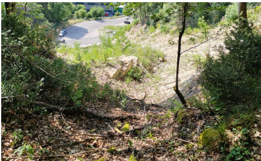
Figura 7-37. Vista dall'alto del ciglio della corona della frana del maggio 2023 ripresa dal fondo canale presso l'area denominata M_003. Si noti il salto morfologico e la scogliera LiE_007 che devia verso destra le acque provenienti dall'incisione, impedendo loro di innescare possibili scivolamenti nelle coltri blandamente vegetate in secondo piano rispetto alla scogliera.
