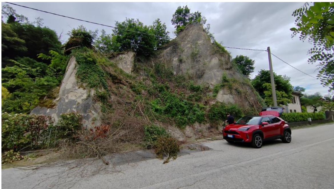
Figura 3-9. Ripresa da terra dello sperone roccioso presente a bordo strada, immediatamente a sud-ovest dell'attraversamento del Rio Ca' Nova, presso il limite settentrionale del sito di Allocco.
