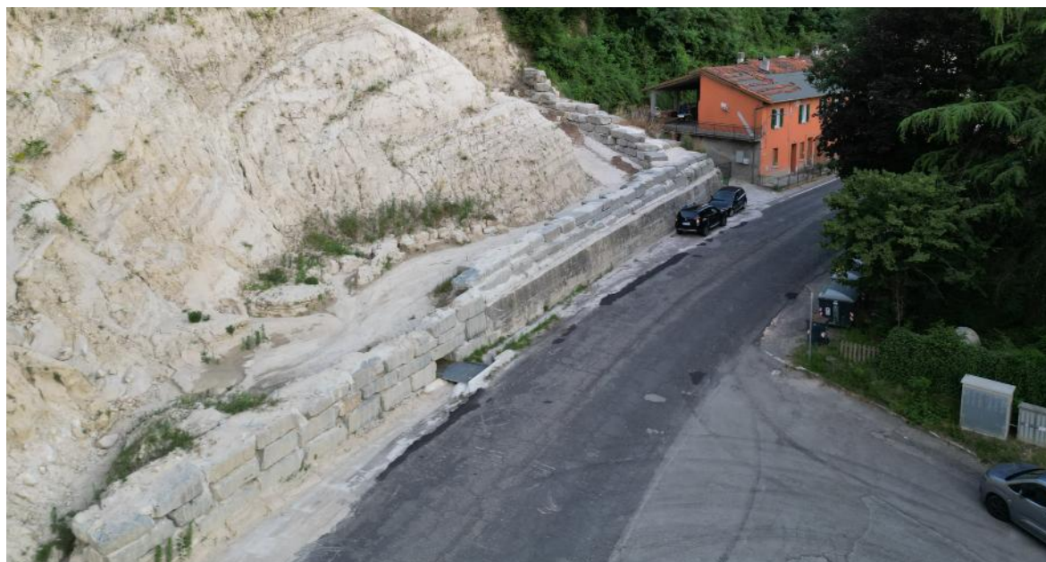
Figura 7-33. Ripresa aerea del muro in faldoni lapidei realizzato al piede del versante successivamente alla sua riprofilatura. Si sovrappone parzialmente al muro in cls che sosteneva il terreno poi rimosso a seguito della frana. Il muro in faldoni si raccorda verso S-E al fianco sinistro di un’incisione lungo la quale, in occasione di precipitazioni, si attiva un corso d’acqua effimero; il muro funge così da argine di contenimento verso valle.
