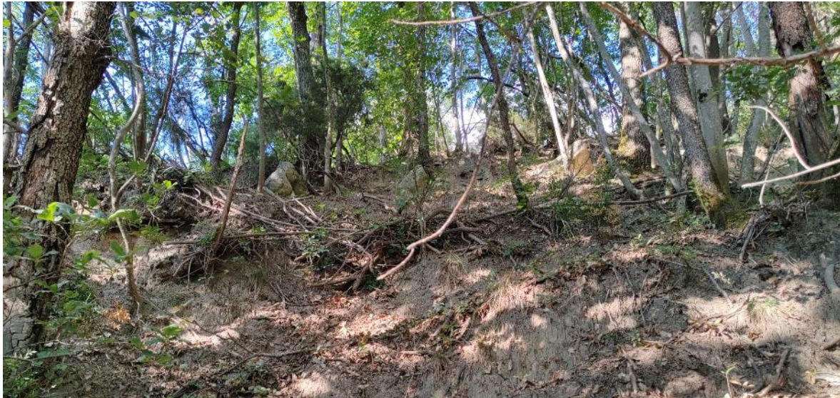
Figura 7-42. Ripresa dal basso dell'area M_005, presso la quale il substrato è soltanto subaffiorante, ma si manifesta con alcuni piccoli speroni sporgenti (riconducibili a strati più competenti) che potrebbero mobilizzarsi. Non può essere del tutto esclusa anche l'instabilizzazione parziale delle coltri che ricoprono il substrato.
