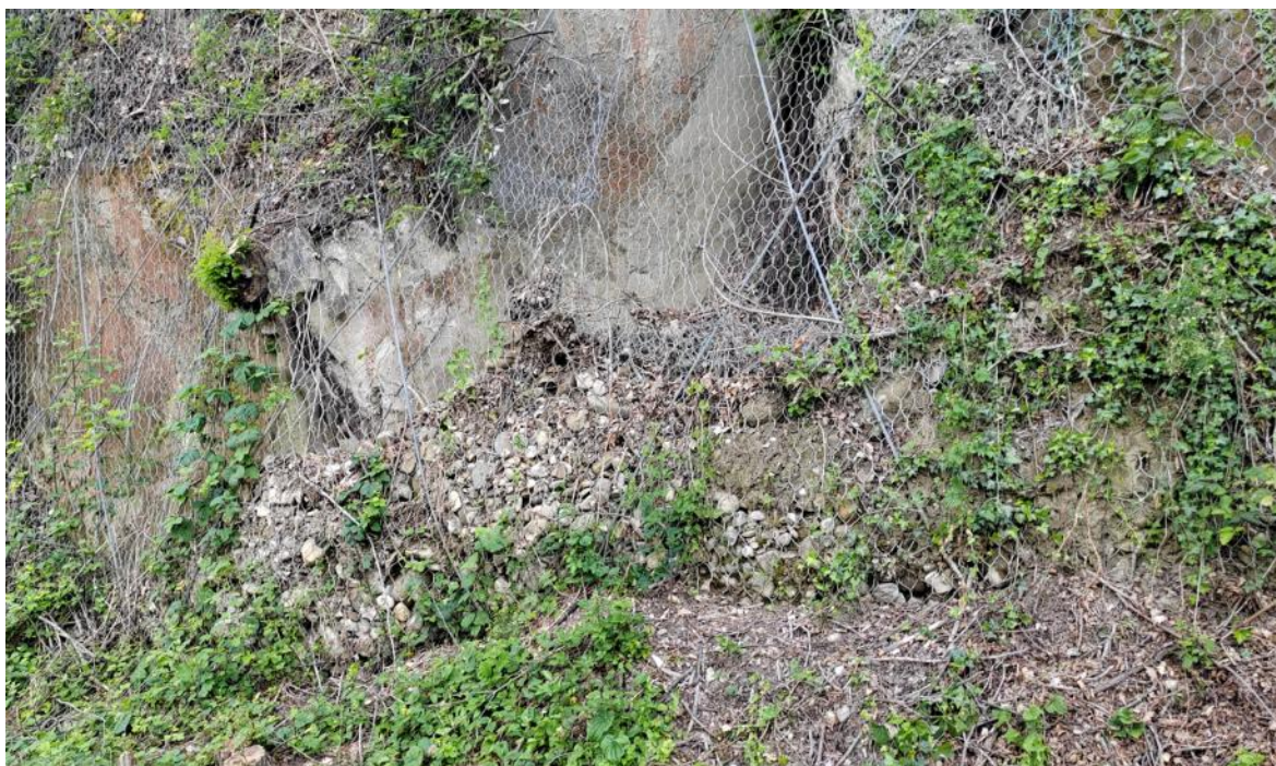
Figura 7-12. Dettaglio di un riempimento a tergo della rete di un rafforzamento corticale. La gran quantità di ciottoli arrotondati testimonia l'instabilità delle corti soprastanti, costituite in parte da depositi alluvionali terrazzati (AES8a).
