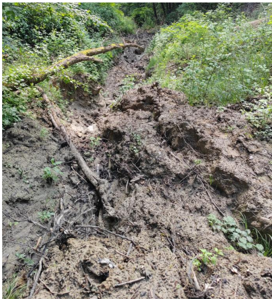
Figura 4-11. Ripresa, da monte verso valle, del deposito di frana attiva per complessa (a1g) individuato nella parte superiore della più settentrionale delle incisioni dell'area di indagine (Bacino 1).
