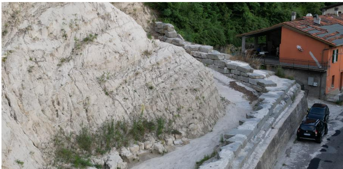
Figura 4-18. Le arenarie della Formazione di Loiano (LOI) al piede del versante messe a nudo in seguito ai dissesti del maggio 2023 ed ai successivi interventi di messa in sicurezza. Da questa vista laterale da nord, si apprezza la componente a reggipoggio dell'assetto della stratificazione.
