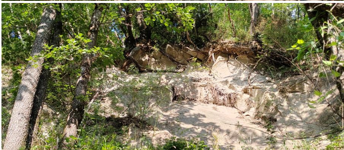
Figura 4-23. Esempi di aree potenzialmente soggette a distacchi di blocchi in virtù della fratturazione dell'ammasso roccioso.
