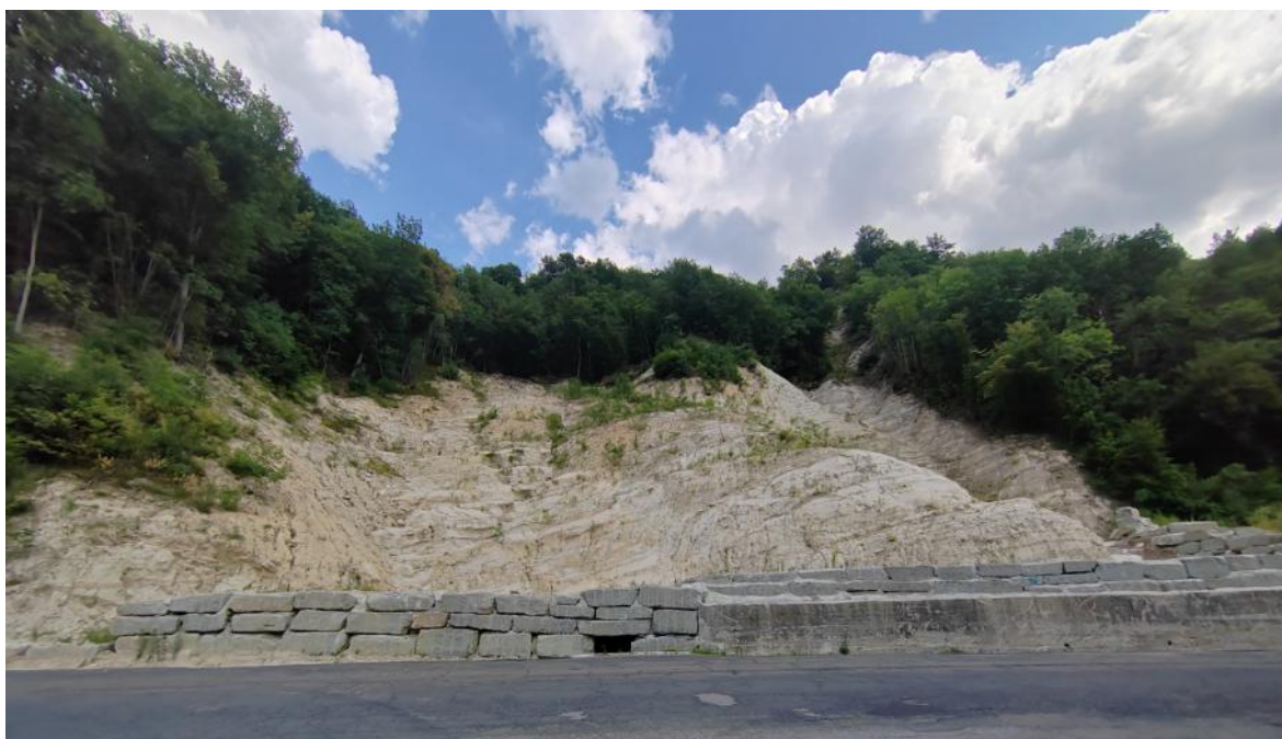
Figura 3-19. Ripresa frontale da terra W-NW della porzione basale dell'area di studio, evidentemente interessata dai dissesti del maggio 2023. In primo piano il muro di contenimento in faldoni lapidei.
