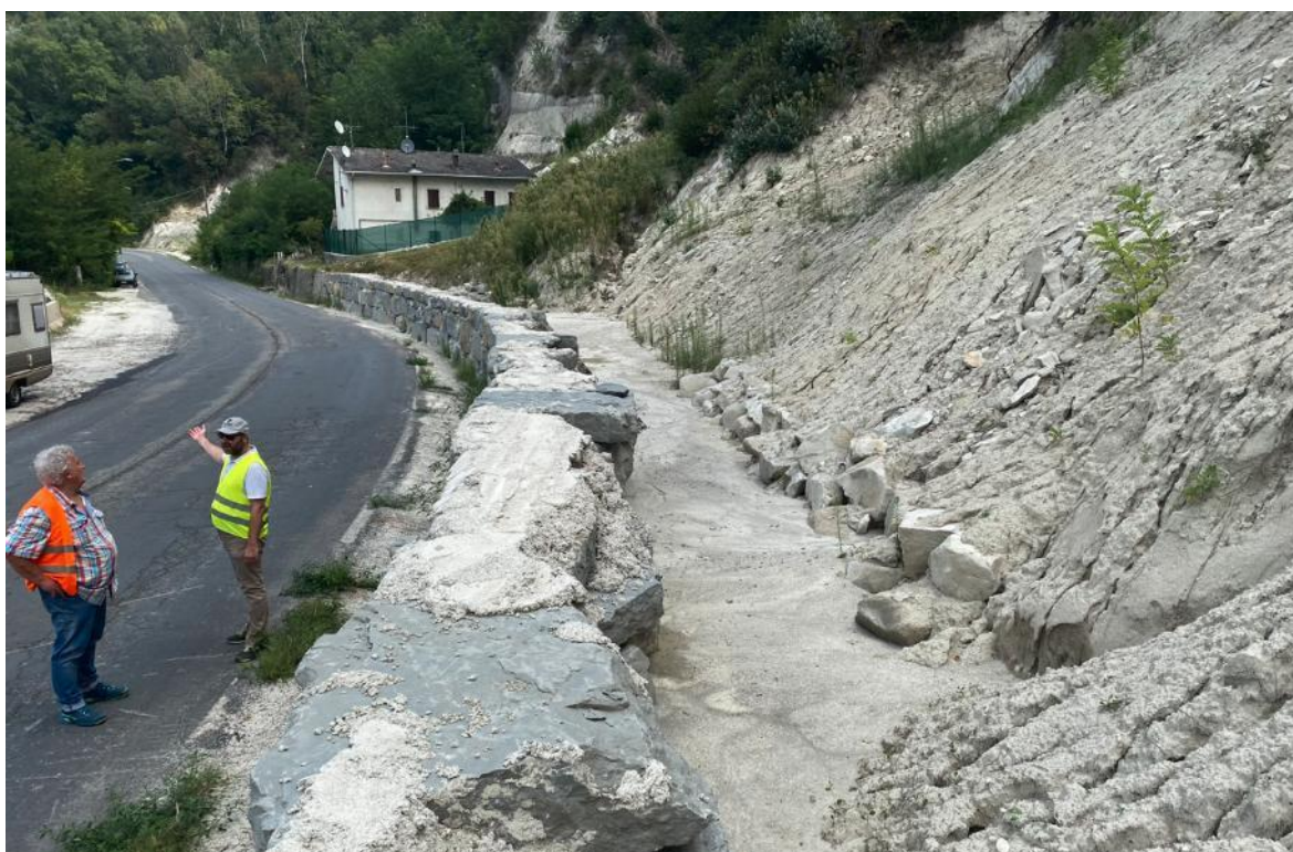
Figura 3-16. Porzione meridionale della tratta stradale attenzionata relativa al sito di Vado (1) ripresa lateralmente dal suo limite sud-ovest.
