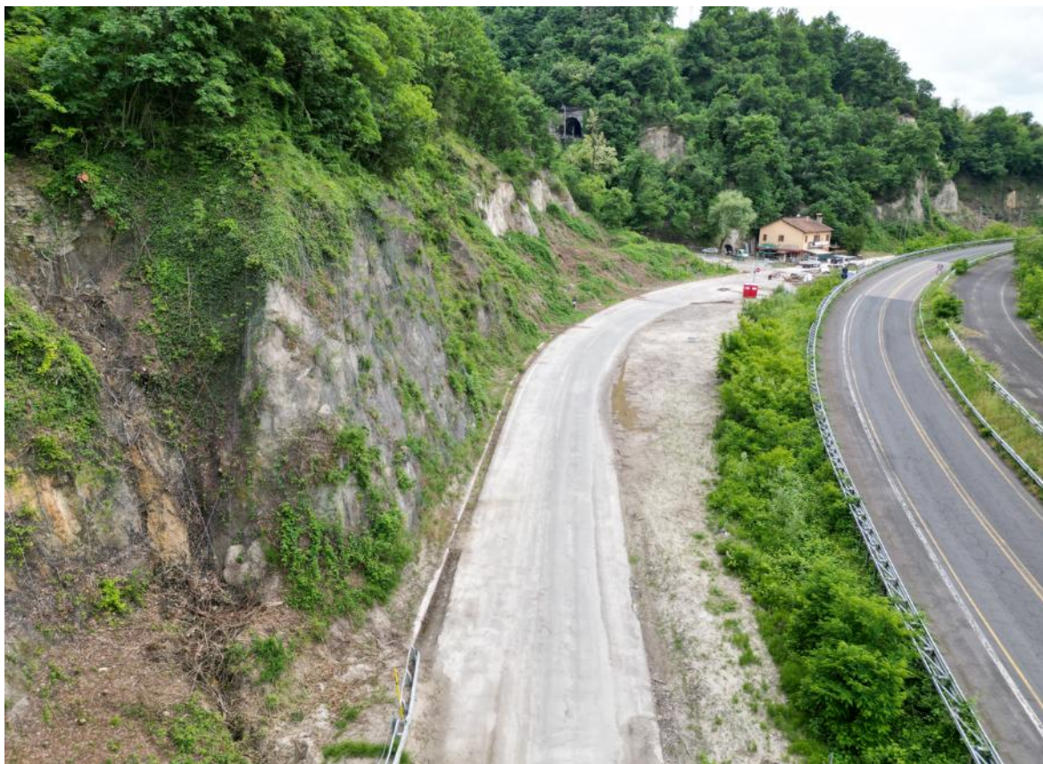
Figura 3-5. Ripresa aerea da nord della SP 325 nella porzione centrale del sito di Allocco. Il Rio Ancini sottoattraversa la viabilità poco prima dell'abitazione visibile in foto.
