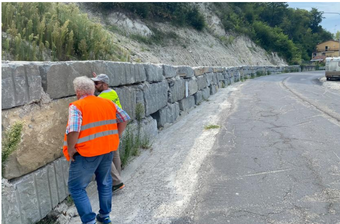
Figura 7-24. Vista laterale del muro di contenimento relizzato in faldoni lapidei.
