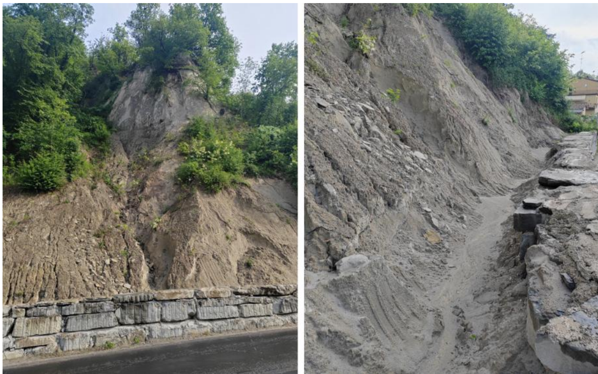
Figura 7-23. Vista frontale e laterale delle riprofilature eseguite al piede del versante nella parte meridionale del sito di Vado (1). Si può osservare come spessori di coltre, prevalentemente sabbiosa, anche superiori al metro siano rimasti in posto, lungo scarpate molto acclivi, che vengono erose dalle acque meteoriche. Grandi quantitativi di sabbia si accumulano pertanto a valle, a tergo del muro. Si notino i solchi erosivi lungo la scarpata riprofilata ed i segni della benna che, lavorando dalla sede stradale, ha rimosso solo parzialmente tali accumuli.
