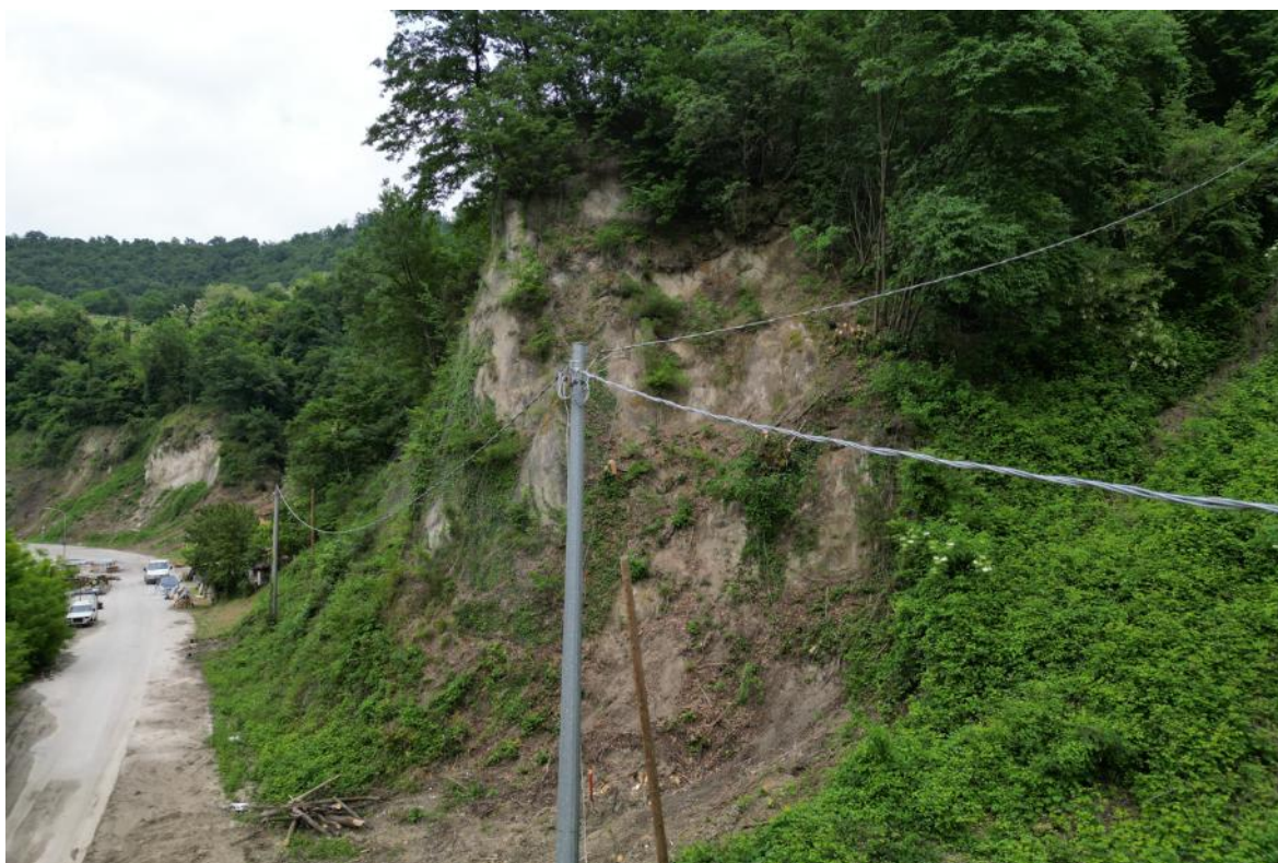
Figura 3-6. Ripresa aerea da sud-ovest della SP 325 nella porzione centrale del sito di Allocco.
