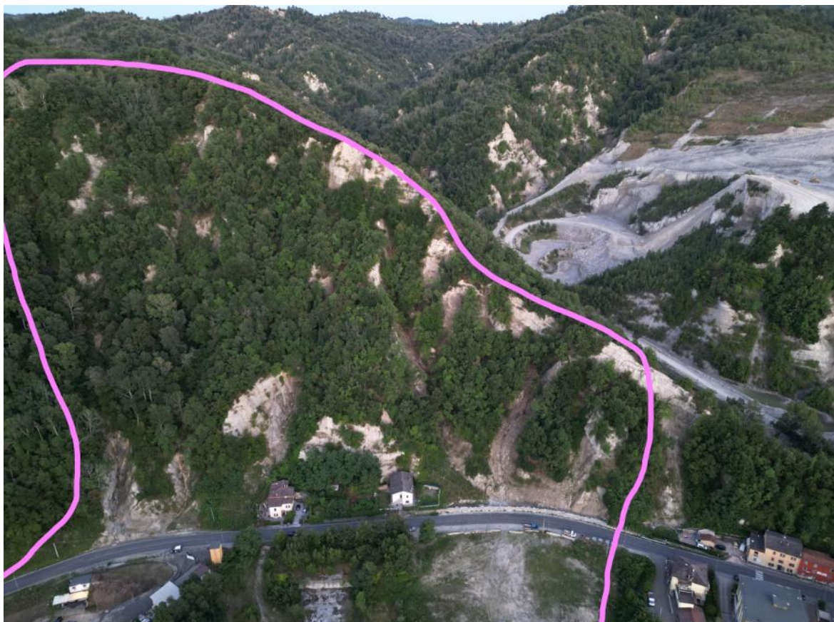
Figura 3-11. Ripresa aerea da nord-ovest della SP 325 e del versante soprastante ricadente nell'area di studio relativa al sito di Vado (1).
