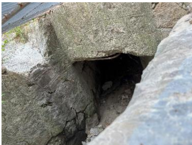
Figura 7-21: Imbocco del collettore presente nel sito di Vado (2)
