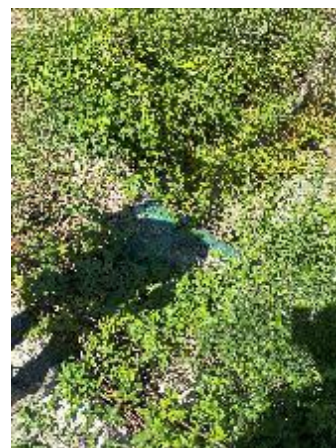
Figura 10-4: Tubazione rete fognaria
