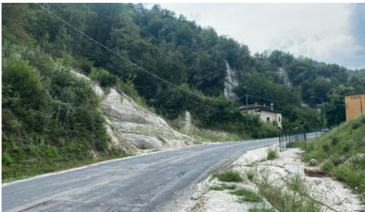
Figura 3-12. Porzione settentrionale della tratta stradale attenzionata relativa al sito di Vado (1) ripresa lateralmente dal suo limite nord.
