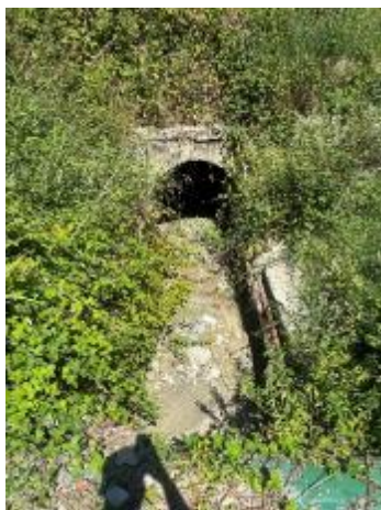
Figura 10-1: Attraversamento Rio Ancini- lato di valle
