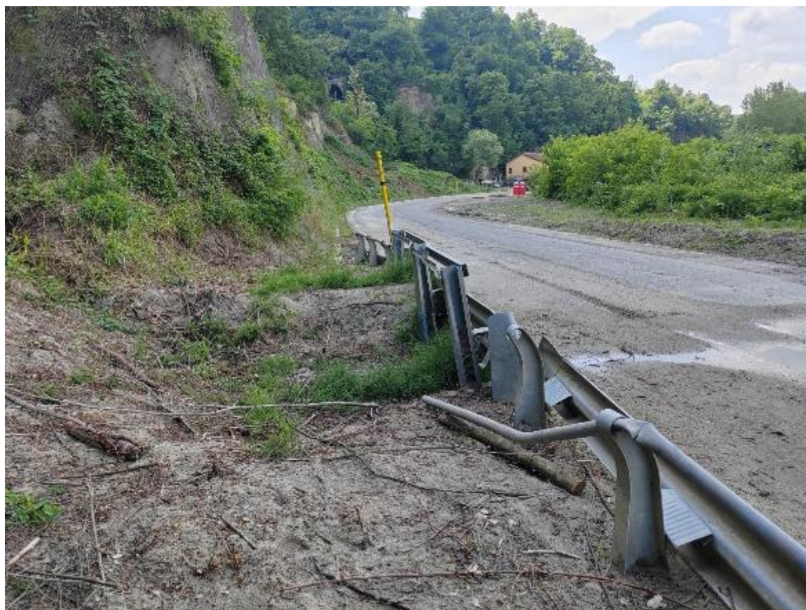
Figura 7-8: Barriere da sostituire
