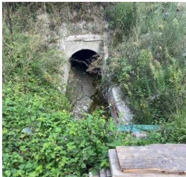
Figura 7-10: Imbocco attuale dell'attraversamento idraulico del rilevato autostradale del Rio Ancini
