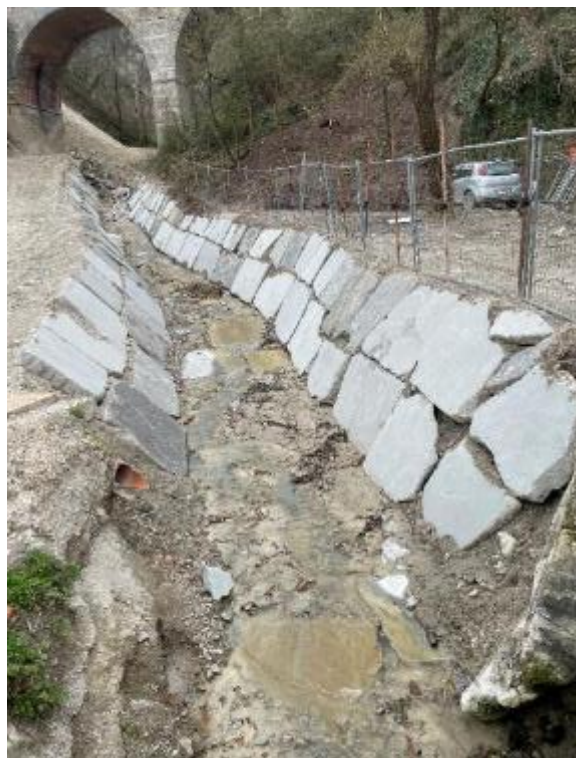
Figura 7-11: Riprofilatura del tratto di Rio Ancini tra viadotto RFI e imbocco dell'attraversamento della SP325
