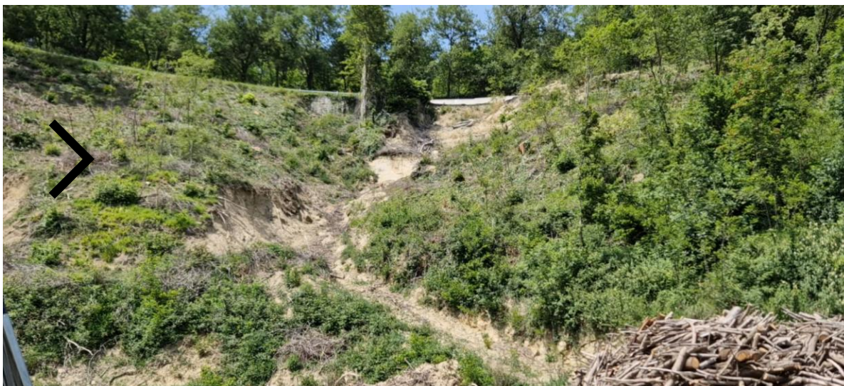
Figura 20: Foto 1: vista della frana dal basso (km 0+300)
