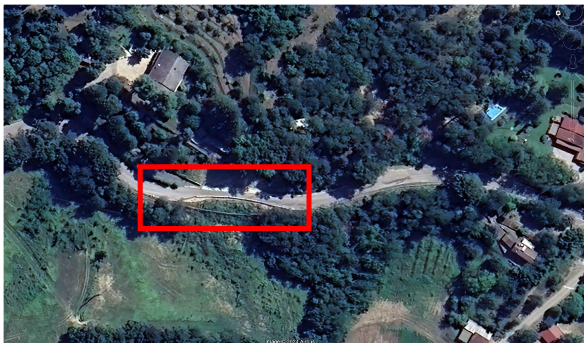
Figura 24: Mappa satellitare della frana al km 2+700
