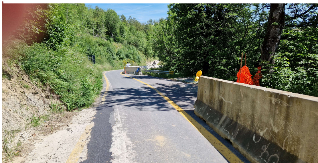
Figura 5: Ulteriori tratti di riduzione della piattaforma causata dalle frane
