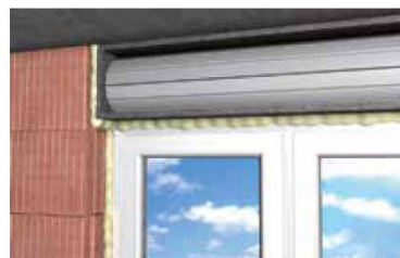
Giunti di connessione intorno ai cassonetti
