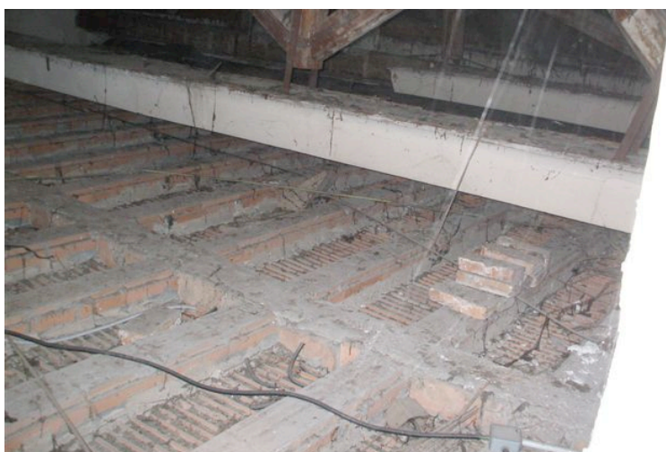
Figura n.5 –Solai non praticabili in sostituzione degli arellati
