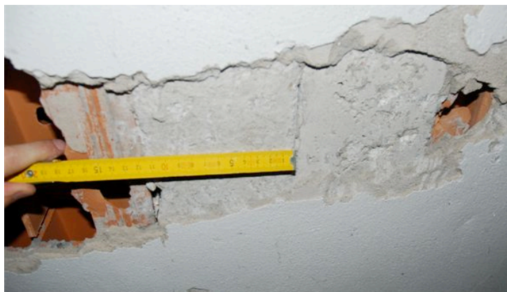
Figura n.12 –Solaio in latero-cemento in sostituzione di solaio esistente
