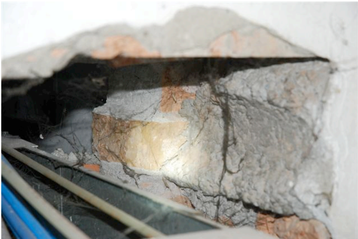
Figura n.9 –Evidente elemento decorativo presente esternamente negli architravi su parete interna
