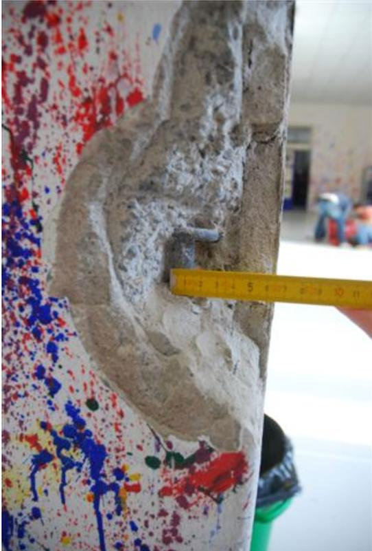
**Foto 70 Saggio pilastro c.a. (saggio S1)**
