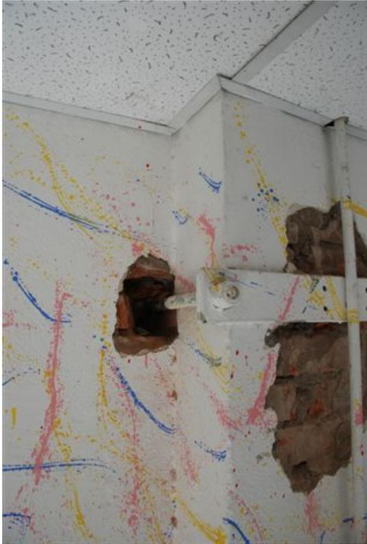
**Foto 78 Saggio pilastro muratura (S4)**
