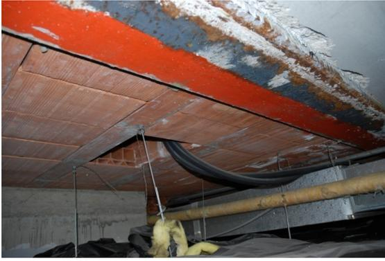
**Foto 180 Travi metalliche e solaio parte scale**
