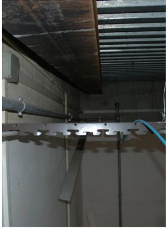
**Foto 93 Saggio solaio in lamiera grecata (S12)**
