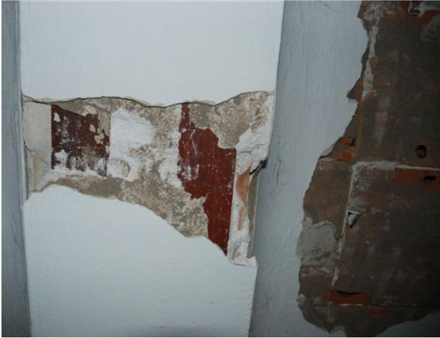
**Foto 86 Saggio su travi reggi solaio (S8)**
