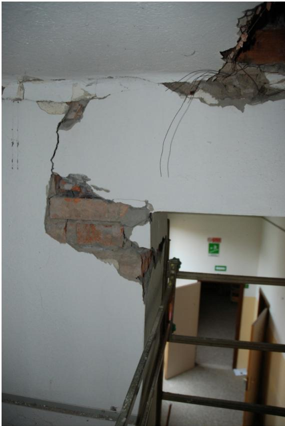
**Foto 124 Saggio appoggio architravi metalliche (S32)**
