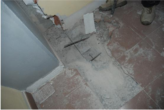
**Foto 174 Saggio connessione trave solaio (S35)**
