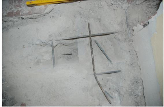
**Foto 175 Saggio connessione trave solaio (S35)**
