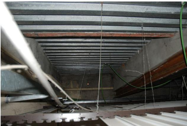
**Foto 94 Saggio solaio in lamiera grecata (S12)**
