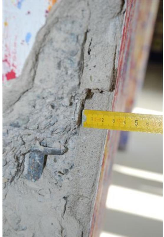
**Foto 71 Saggio pilastro c.a. (S1)**
