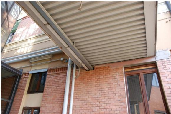
**Foto 7 Dettaglio su corpo centrale di passerella di collegamento poggiante su parete**
