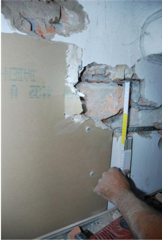
**Foto 92 Saggio su travi reggi solaio (S11)**
