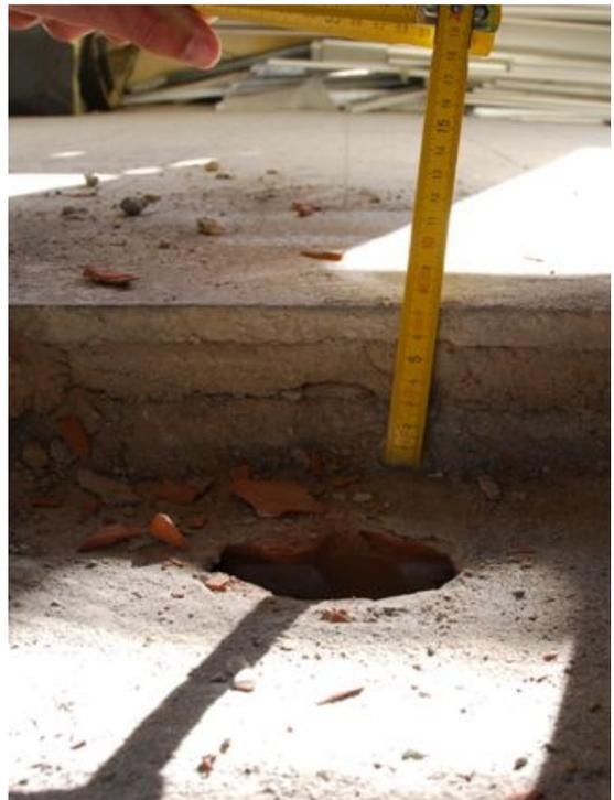
**Foto 85 Saggio solaio tipo S1 (S7)**
