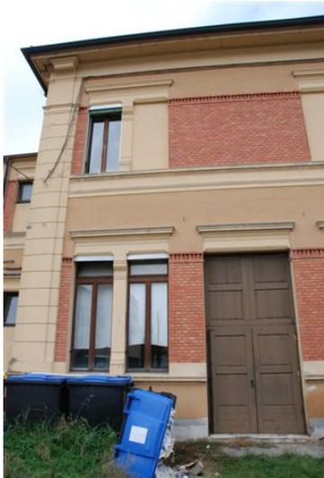
**Foto 9 Dettaglio lato corto ali con aperture tamponate**
