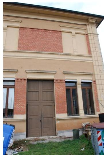
**Foto 10 Dettaglio lato corto ali con aperture tamponate**
