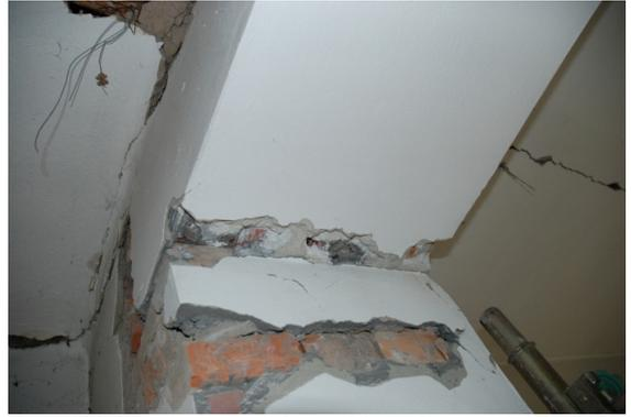
**Foto 123 Saggio appoggio architravi metalliche (S32)**
