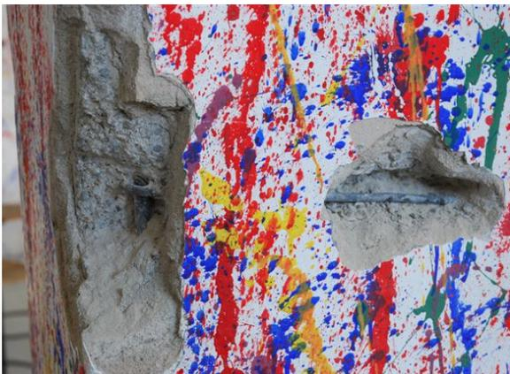
**Foto 72 Saggio pilastro c.a. (S1)**
