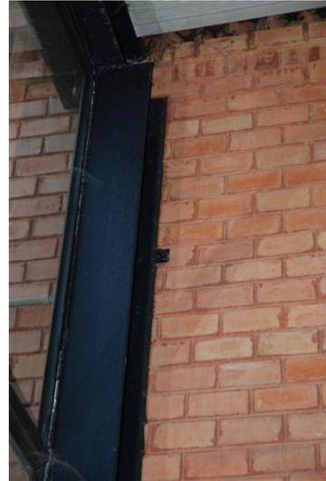
**Foto 6 Dettaglio collegamento pilastri per corpo esterno metallico in corrispondenza del corpo centrale**
