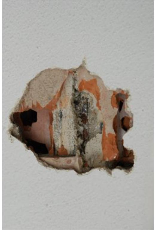
**Foto 83 Saggio solaio tipo S1 (S7)**
