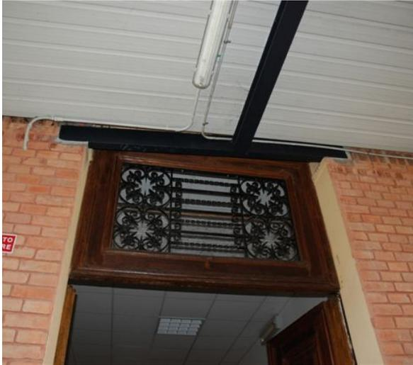
**Foto 5 Architrave metallico per sostegno coperto in lamiera in corrispondenza del corpo centrale**
