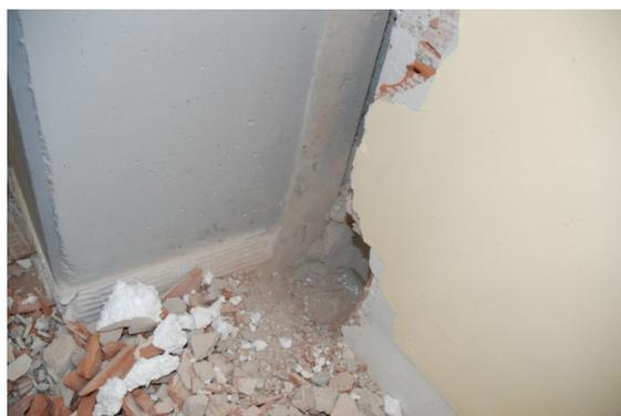
Foto 173 Saggio pilastro tamponatura (S35)
