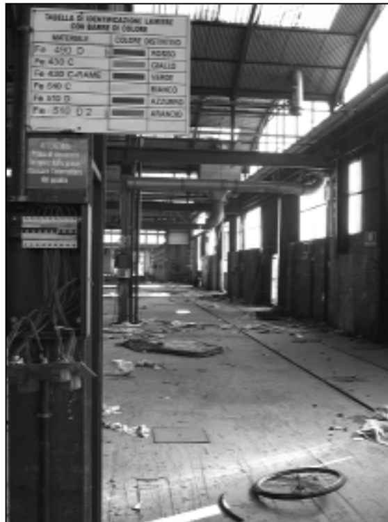
Foto2: Interni della fabbrica Casaralta
