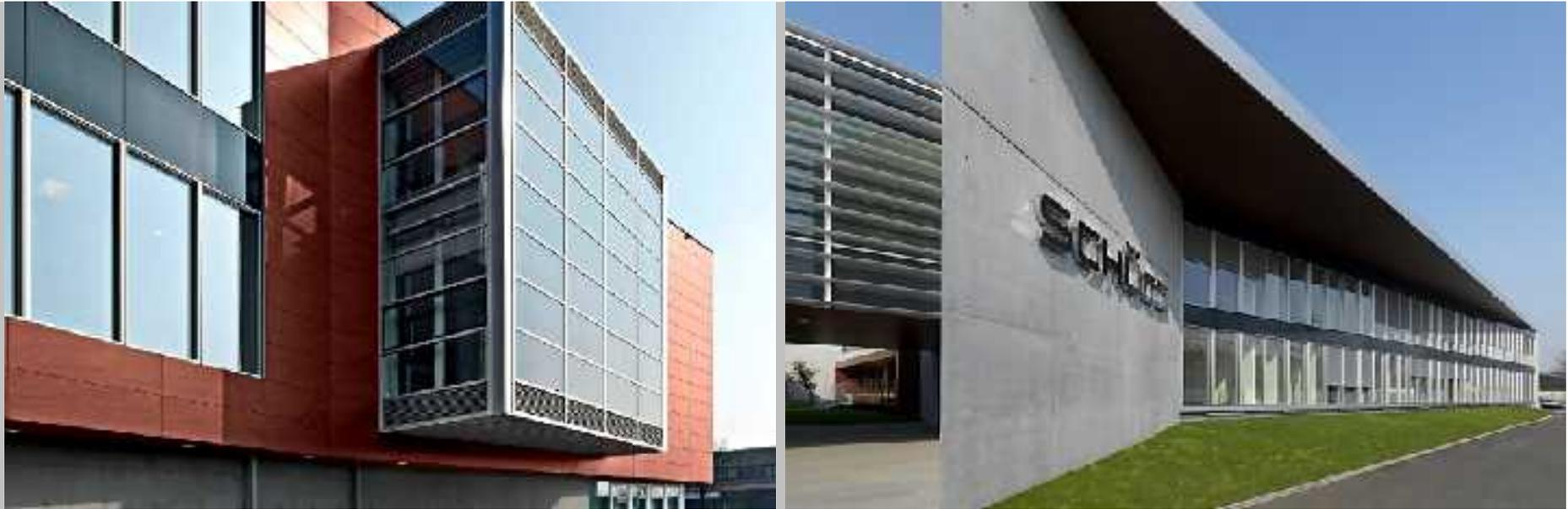
Facciata a doppia pelle con elementi fotovoltaici e finestre a tutta altezza, dotate di vetrocamera ad alte prestazioni e munite di particolare schermatura, costituita da microlamelle frangisole che si attivano quando l'irraggiamento della superficie esterna supera valore di soglia.
