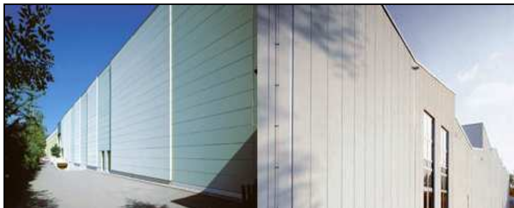
Fig. 20 – calcestruzzo cellulare autoclavato, realizzazione con pannelli montati in orizzontale e montati in verticale.
