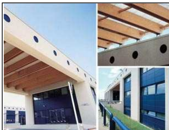
Fig. 12 – Stabilimento Campari a Novi Ligure (Alessandria), il legno lamellare è utilizzato sia nei porticati esterni sia nelle coperture con lucernari.
