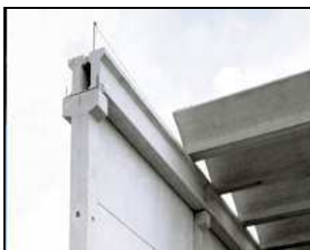
Fig 8 e 9 – travi prefabbricate in cls per la struttura di copertura di edifici industriali e carro ponte che corre lungo l'asse longitudinale della trave in cemento armato
