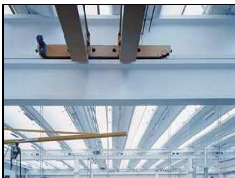
Fig 8 e 9 – travi prefabbricate in cls per la struttura di copertura di edifici industriali e carro ponte che corre lungo l'asse longitudinale della trave in cemento armato
