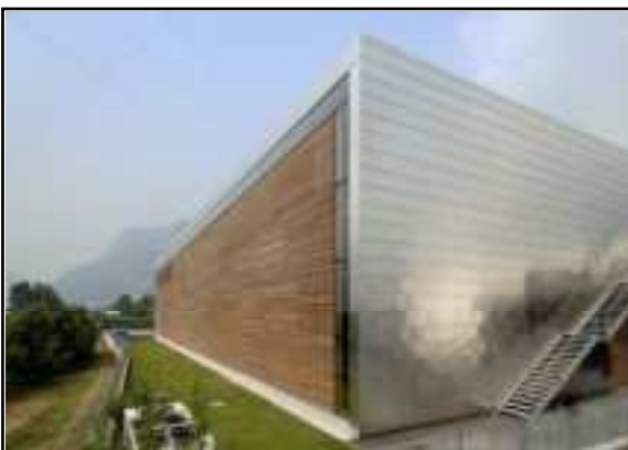
Fig. 37 - nuova sede della Rotho Blaas – la parete a nord.
