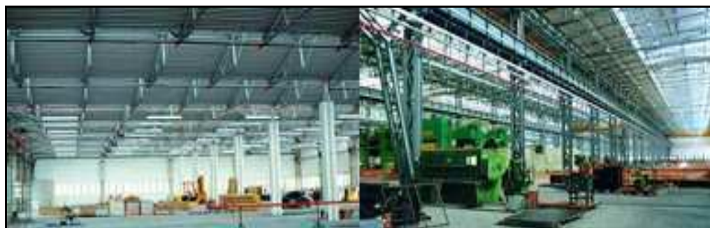
Fig. 10 – stabilimenti con strutture di copertura in acciaio
