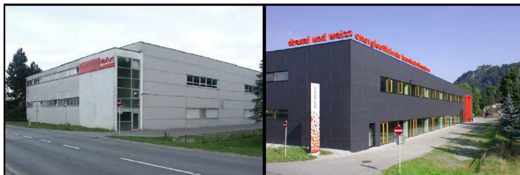
Fig. 32 Lo stabilimento Drexel & Weiss a Wolfurt (Austria), prima e dopo la ristrutturazione su progetto di Gerhard Zweier.
