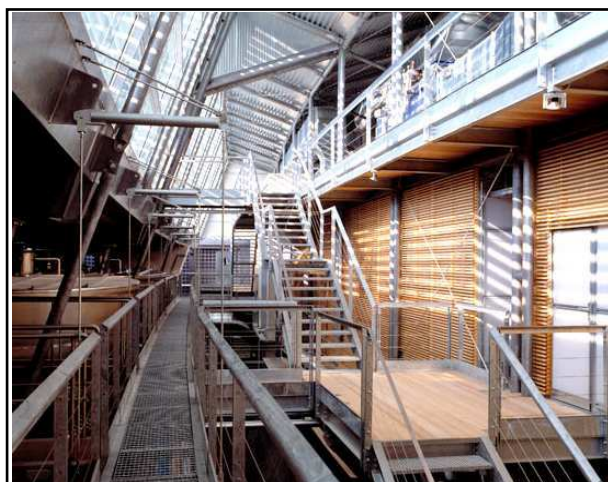
Fig. 19 - Nuova Cantina di Vinificazione a Mezzacorona (Tn.) progettata dallo Studio Cecchetto - dettaglio dei telai e della copertura in lamiera grecata appoggiata su tubi – Le fotografie sono state scattate da Luca Campigotto (Studio Cecchetto) e tratte dal sito www.promozioneacciaio.it
