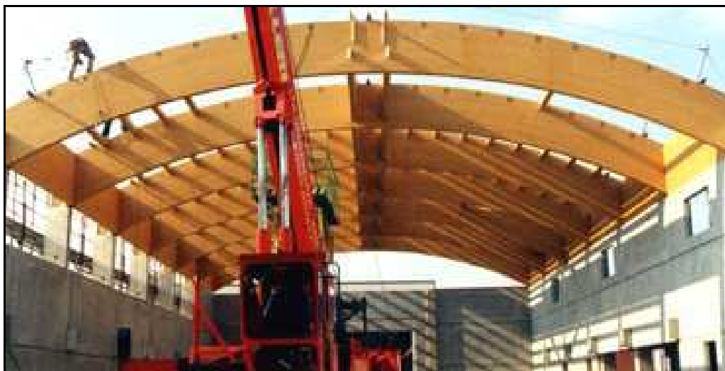
Fig. 11 – particolare della struttura di copertura in legno lamellare - Valeggio sul Mincio (Vr) – Edificio ad uso industriale, realizzato da Moretti Industria delle Costruzioni.
