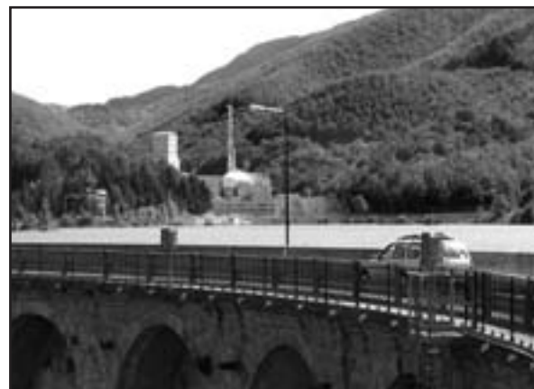
Scorcio della diga del Brasimone (foto F. Gardini)
