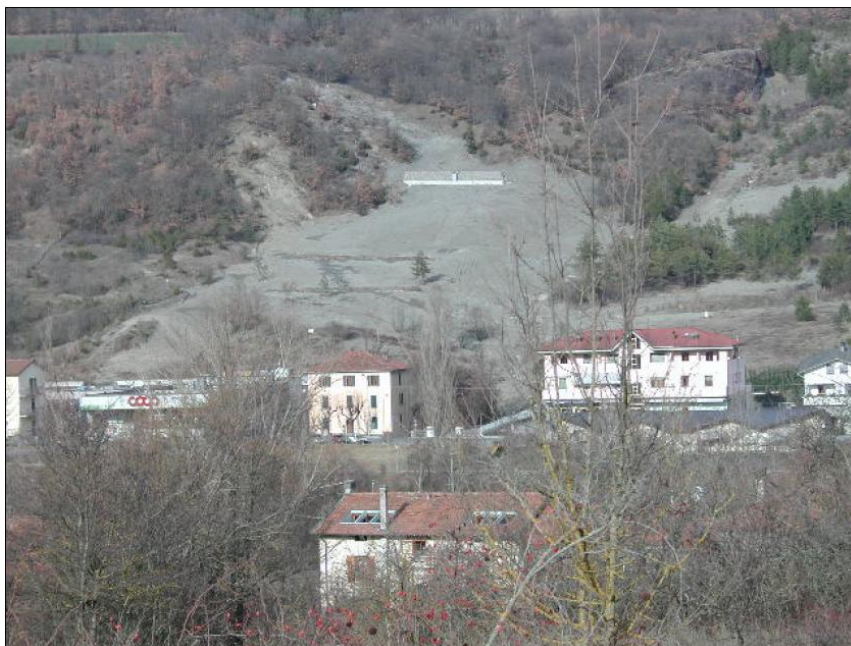
Fig. 5. Panoramica dei movimenti franosi A e B.
