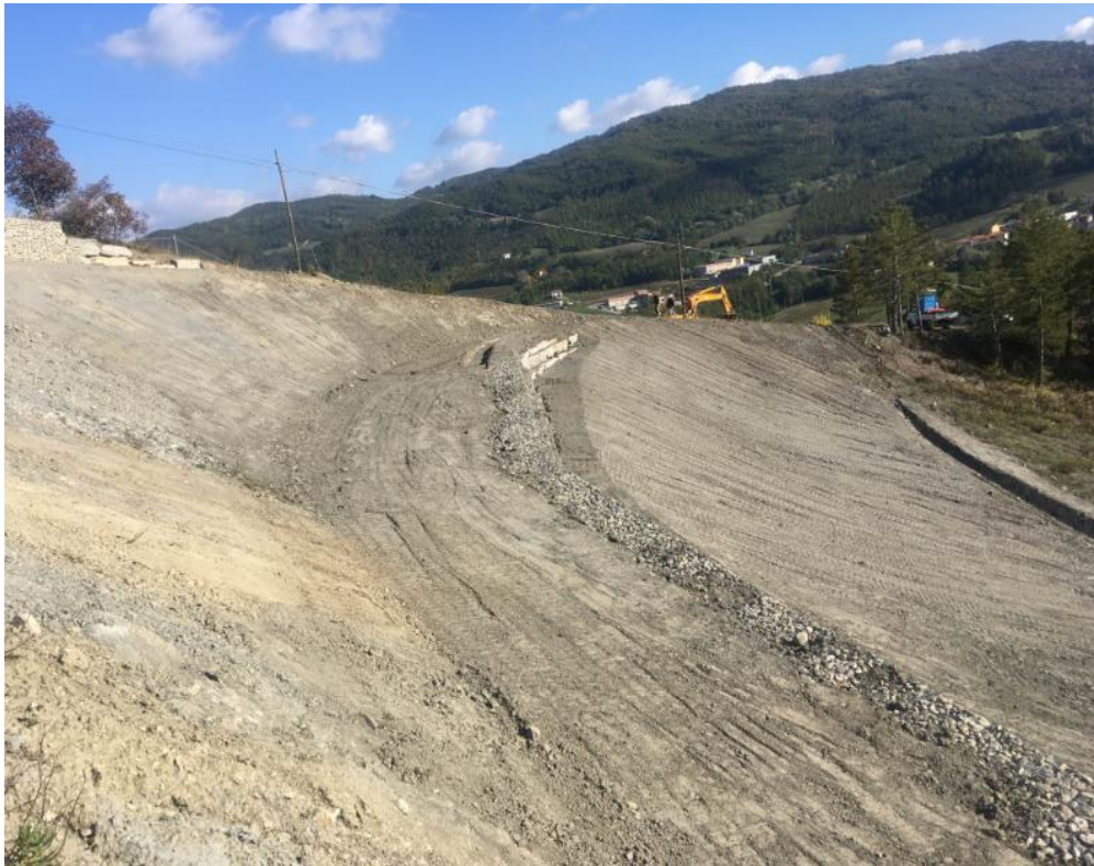
Consolidamento frana a monte dell'abitato di Silla in località Muiavacca – Comune di Gaggio Montano Costo € 148.678,71
