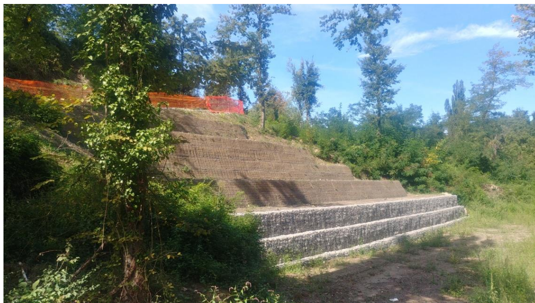
Intervento di consolidamento dei versanti in località Cà Nova Michela in Comune di Monghidoro
