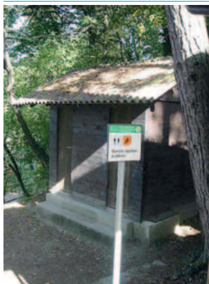
SERVIZIO IGIENICO ACCESSIBILE AI DISABILI
