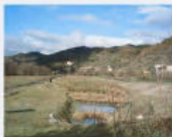
A Dicomano (FI 3500 abitanti) è in funzione il più grande impianto di fitodepurazione per il trattamento secondario di scarichi civili.
