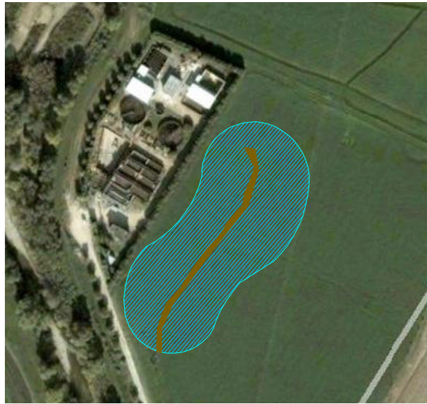
Figura 5: Vista area dell'area interessata dal sistema di post-trattamento
