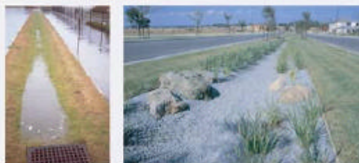
Esempi di canali filtranti realizzati in Germania: in tempo di pioggia e di asciutto
