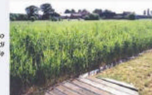
Impianto a flusso sommerso per il trattamento di scolmatori di reti miste (Germania)
