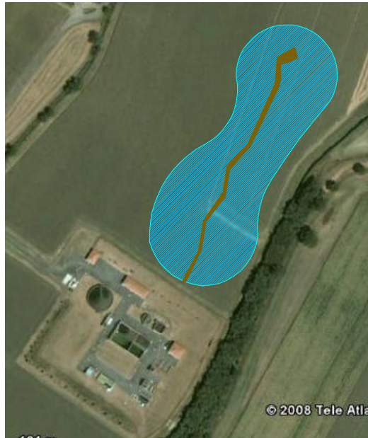
Figura 24: Vista aerea dell'area del post-trattamento
