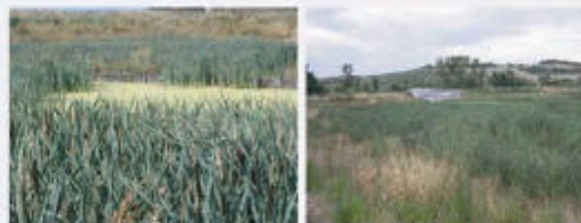
Il postrattamento del depuratore di Jesi (AN 60.000 abitanti) permette di riusare per raffreddamento industriale parte dello scarico
