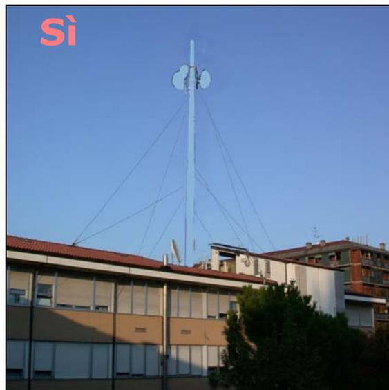
5. in caso di utilizzo di tralicci, prediligere quelli di ridotta sezione e di forma piramidale;
