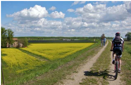
Argine Secchia (MO)
