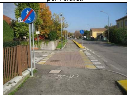
Attraversamento efficace, il segnale di fine percorso deve essere rimosso in quanto il percorso prosegue oltre l'attraversamento
