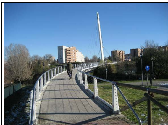
La passerella a sud che si raccorda con la ciclabile del Reno da Bologna
