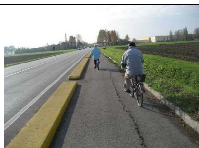
Il percorso prosegue verso sud in destra di buona qualità, un po' carente la segnaletica orizzontale ed i pittogrammi
