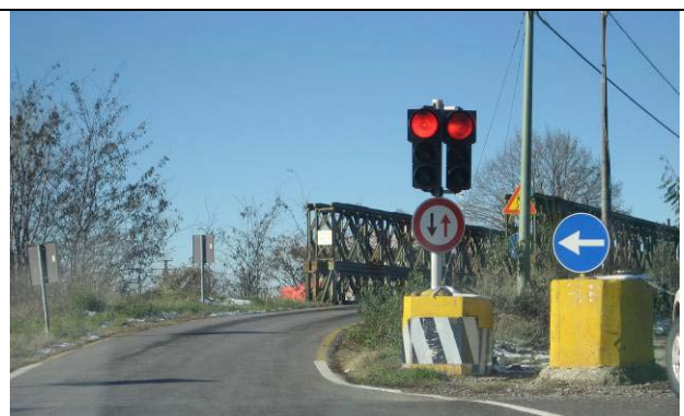
Il ponte esistente sul Lavino
