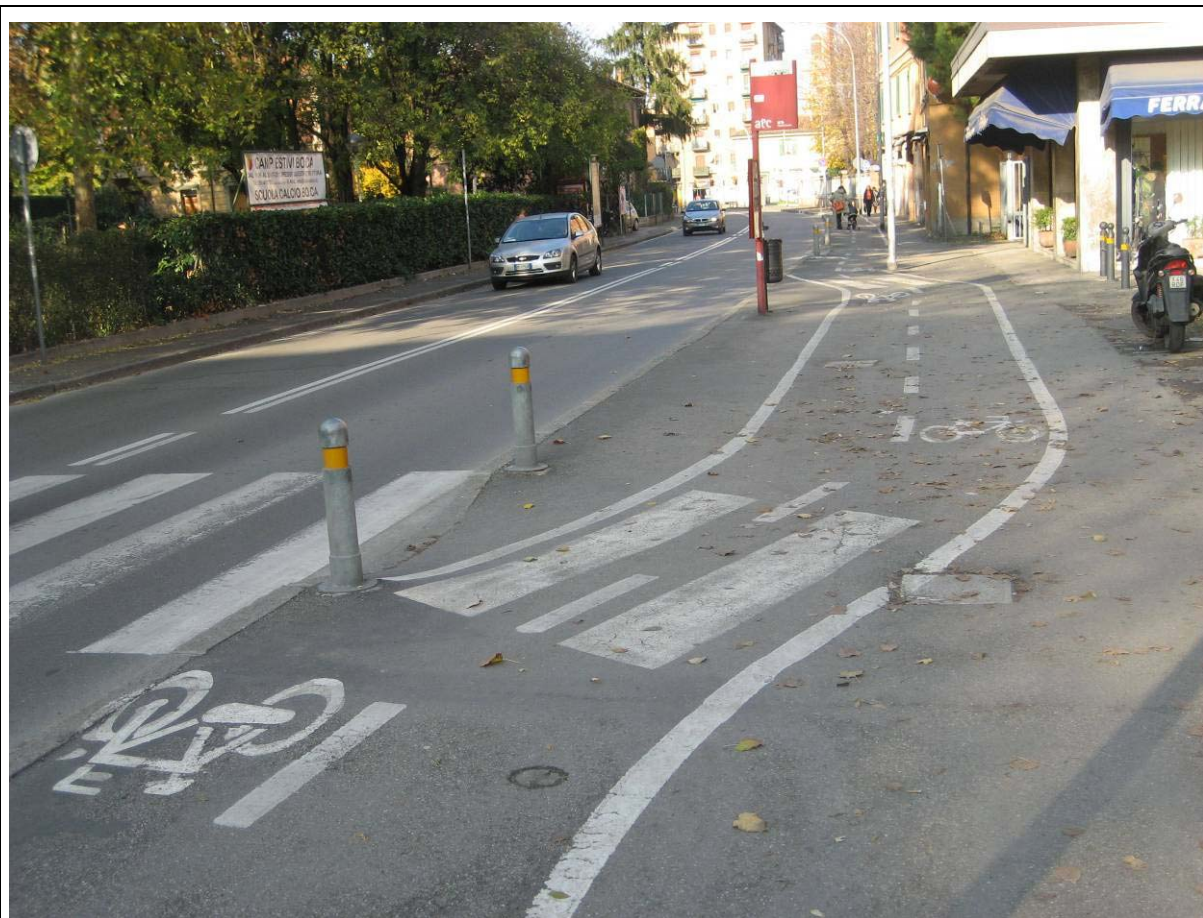
Bologna, via Arcoveggio, buona soluzione per la fermata del Trasporto Pubblico mediante arretramento del percorso ciclabile, notare gli attraversamenti pedonali sulla ciclabile
