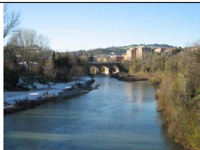
Il Reno dalla passerella verso il ponte di Casalecchio
