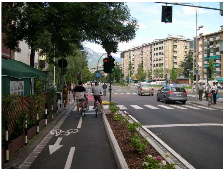
Elemento separatore realizzato con doppio cordolo e riempimento verde.
