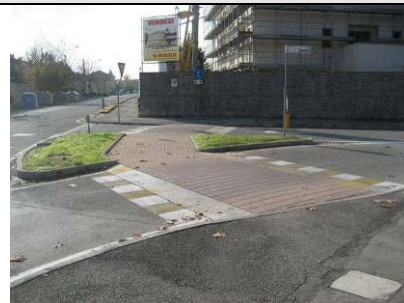
Attraversamento efficace in corrispondenza di via Buozzi
