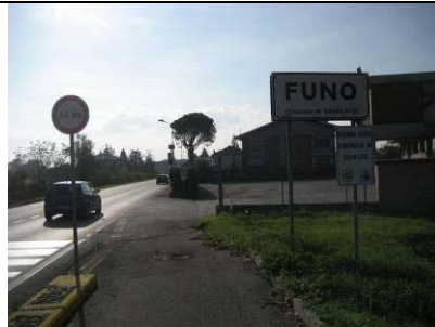
Arrivo a FUNO - Situazione degradata, la pista si stringe a dimensioni di circa un metro bidirezionale
