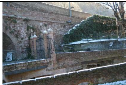
La scala che opportunamente attrezzata con un canalina per la bicicletta ed un a segnaletica consentirebbe di raccordare la ciclabile da Bologna alla passerella di Casalecchio
