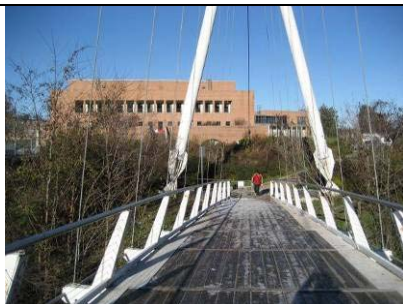
La passerella a nord che raccorda la ciclabile del Reno da Bologna al municipio di Casalecchio
