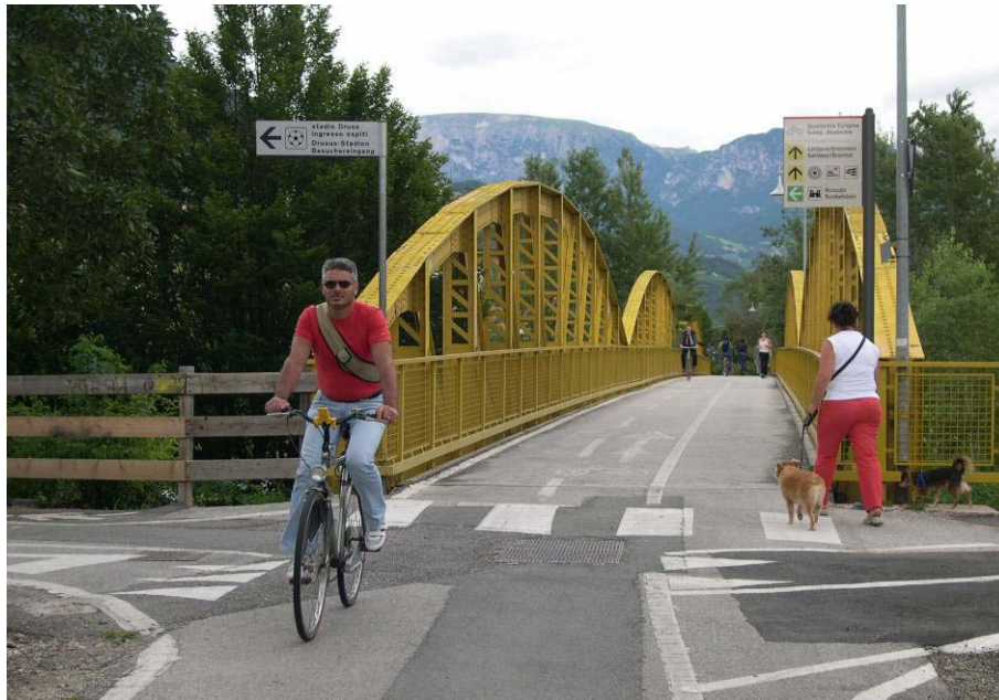
Bolzano, attraversamento tra ciclabili
