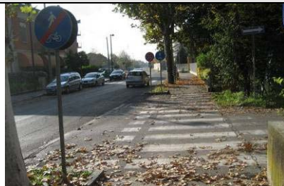
Attraversamento ciclopedonale promiscuo poco riconoscibile e poco vantaggioso per i ciclisti, il segnale di fine percorso deve essere rimosso
