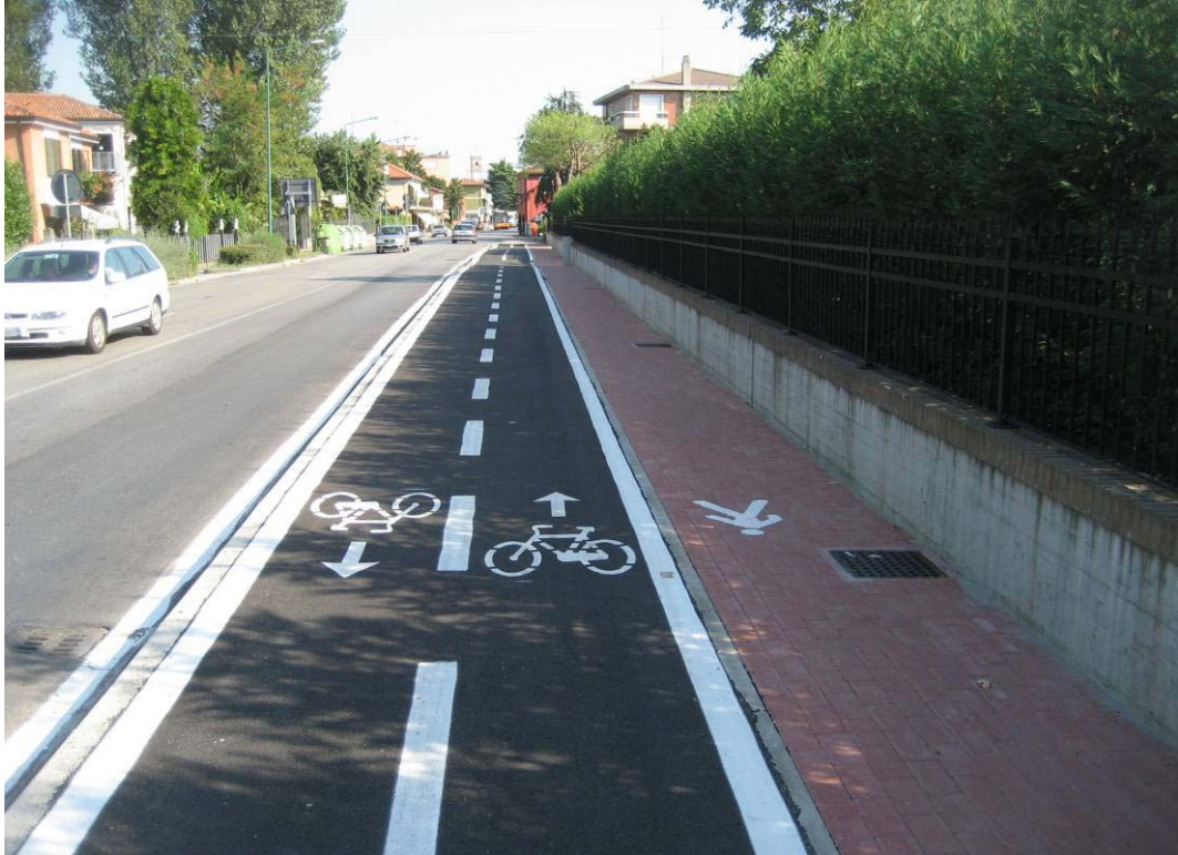
Mestre, delimitazione con segnaletica e cambio di pavimentazione
