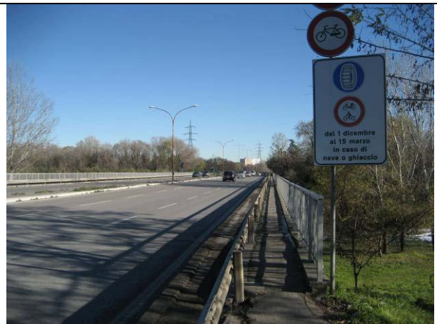
Il percorso sul ponte dell'asse di sud-ovest (ponte tra Casalecchio e Bologna)
