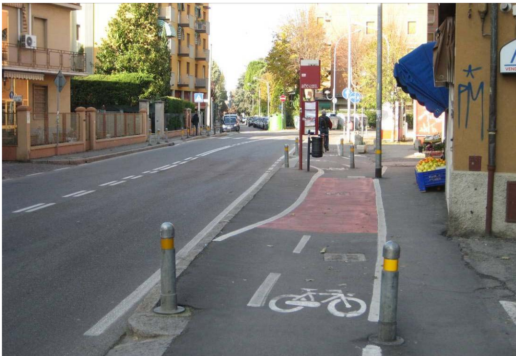
Bologna, via Arcoveggio, buona soluzione per la fermata del Trasporto Pubblico mediante restringimento puntuale della pista ciclabile, il restringimento e il transito dei pedoni viene evidenziato con una coloritura rossa della pavimentazione
