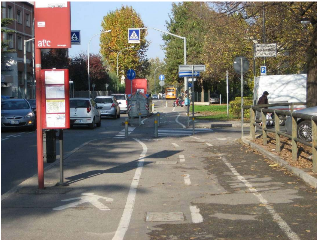
Bologna, via Arcoveggio - esempio di buona ciclabile urbana, per chiarezza di segnaletica orizzontale e spazi dedicati a ciclisti, pedoni e attesa bus
