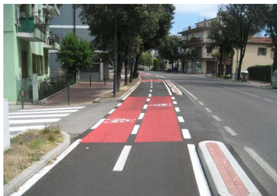
Mestre, (separazione con doppio cordolo e masselli in cls colorati)
