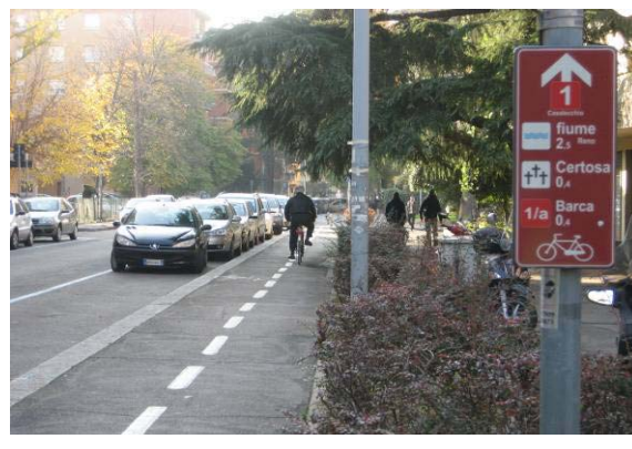
Bologna, (separazione con posizione a quota marciapiede, attenzione all'apertura della portiera dell'auto)
