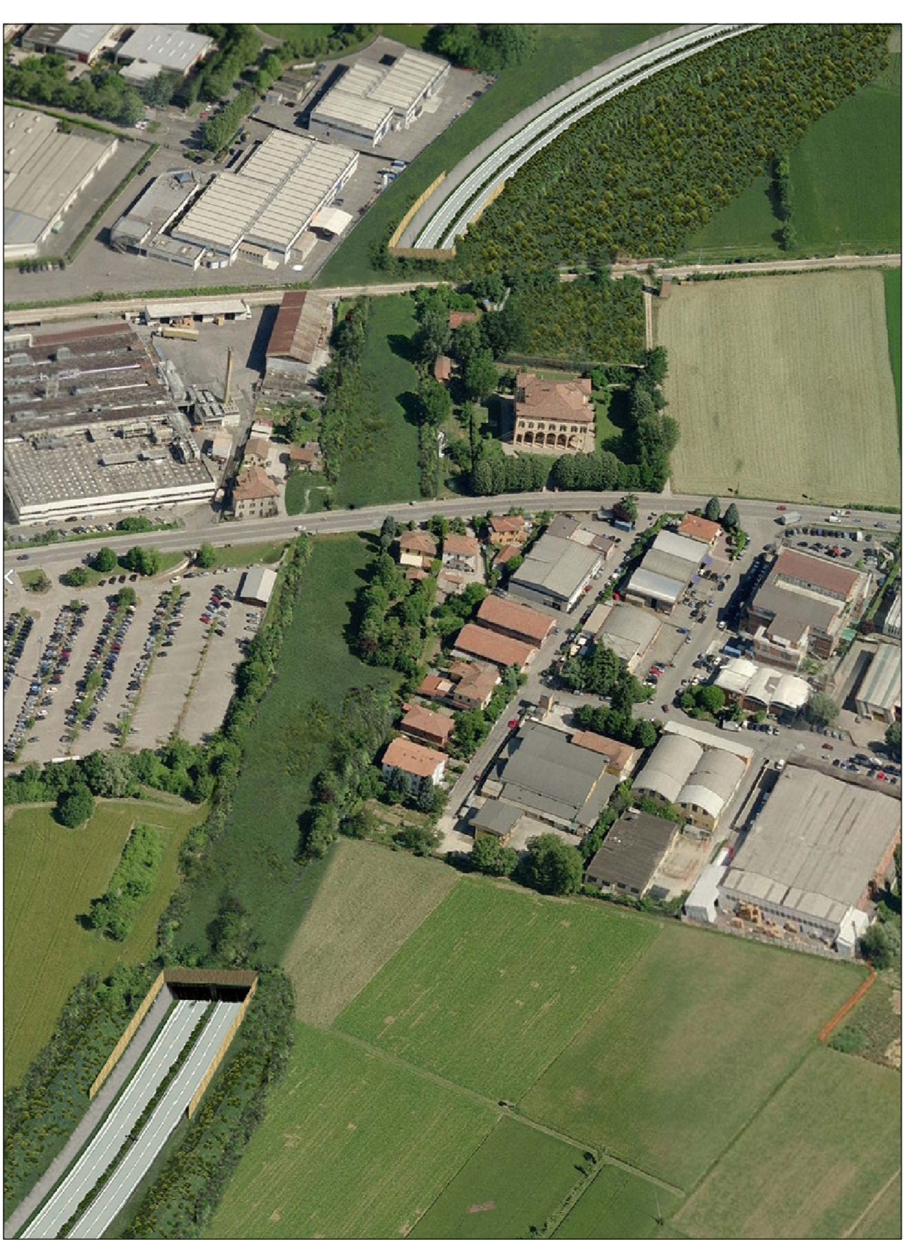
VISTA 2 - TRATTO CENTRALE
