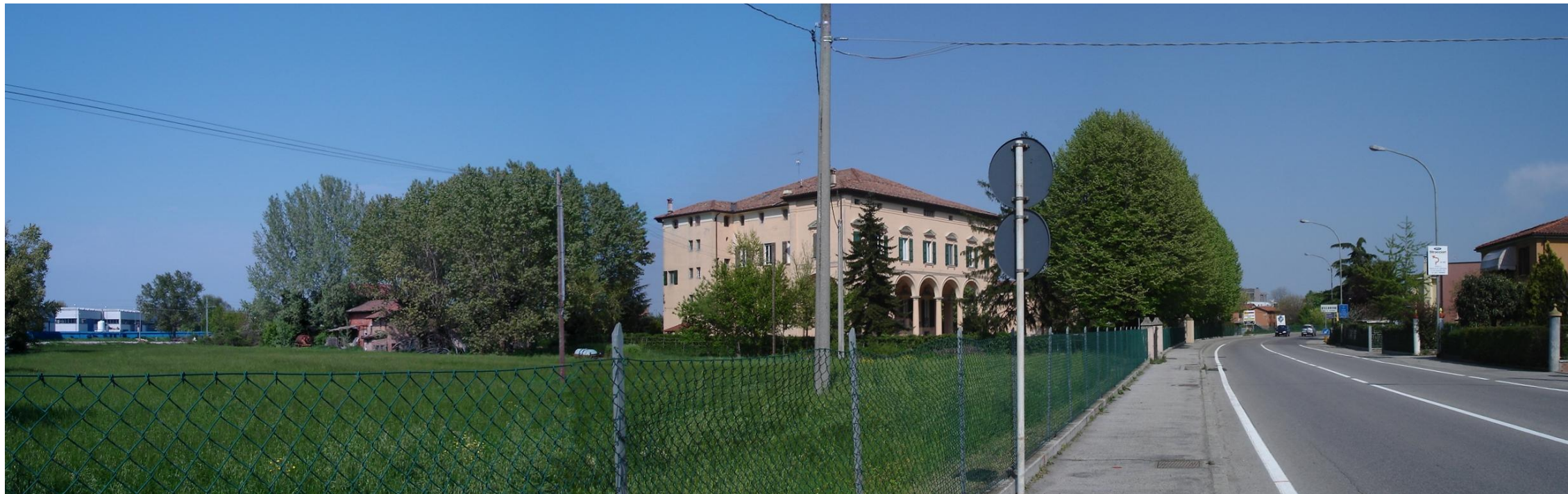
Vista 13 - Scorcio sul "varco" verso nord dalla via Mattei , con villa Marsigli
