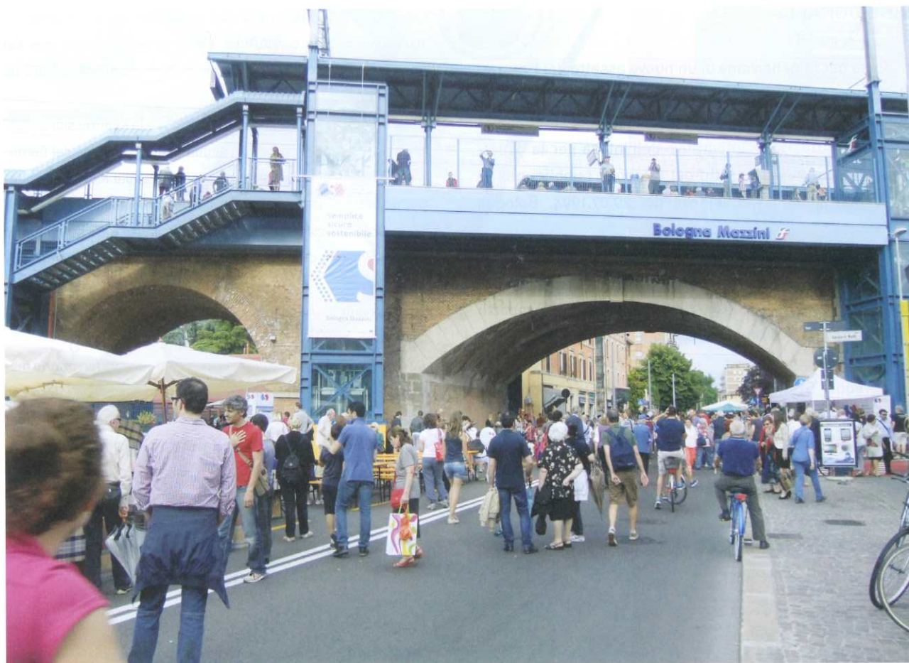
Figura 16 - Stazione Bologna Mazzini
