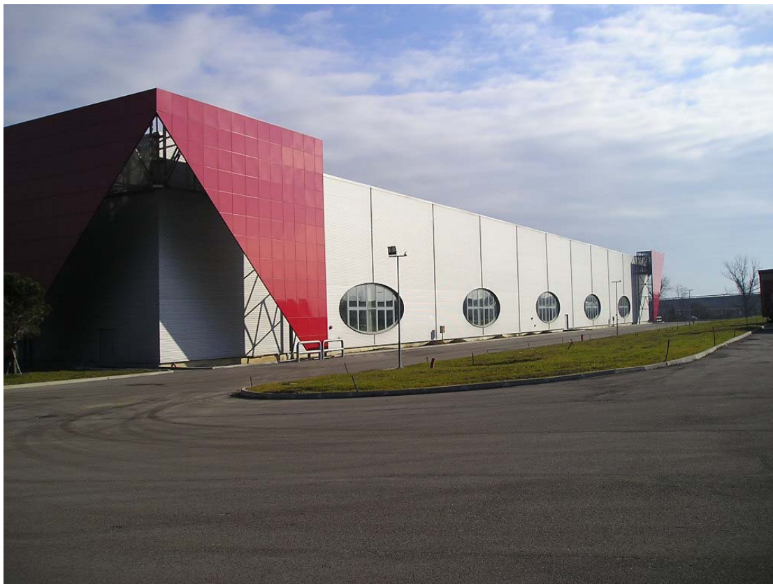
Foto 3 Una vista dello stabilimento della Ford Arcese
