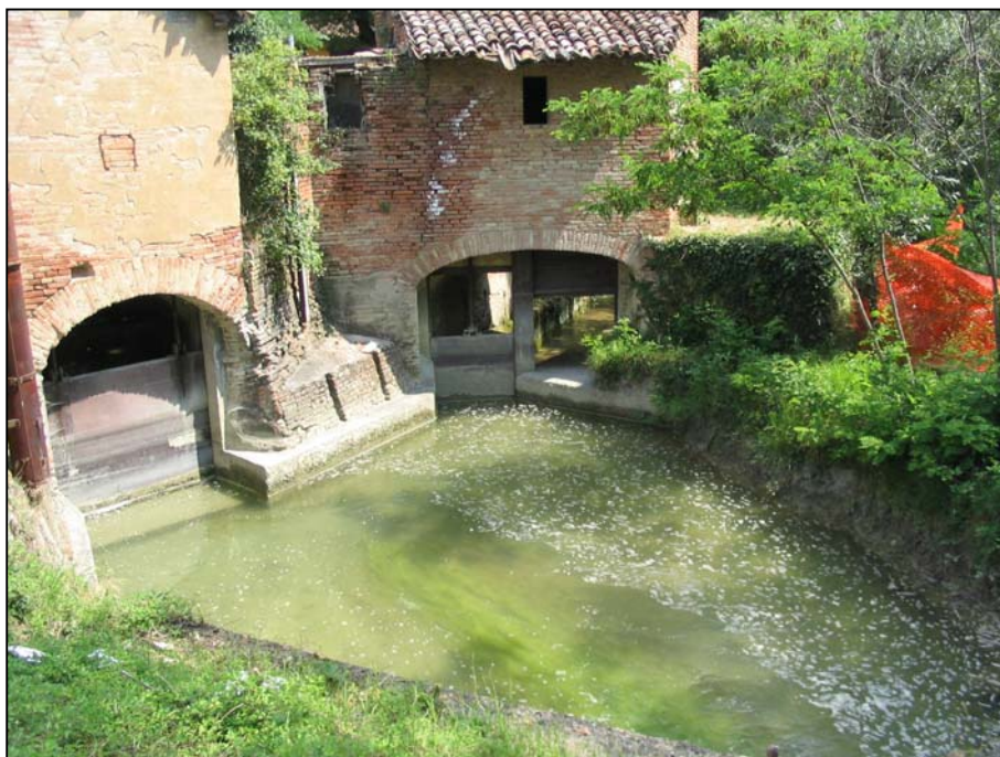
foto n. 2 – L'edificio della Chiusa: si noti la biforcazione che a destra riconduce l'acqua sottratta al Sillaro allo stesso torrente e a sinistra comincia il tracciato del Canale di Medicina
