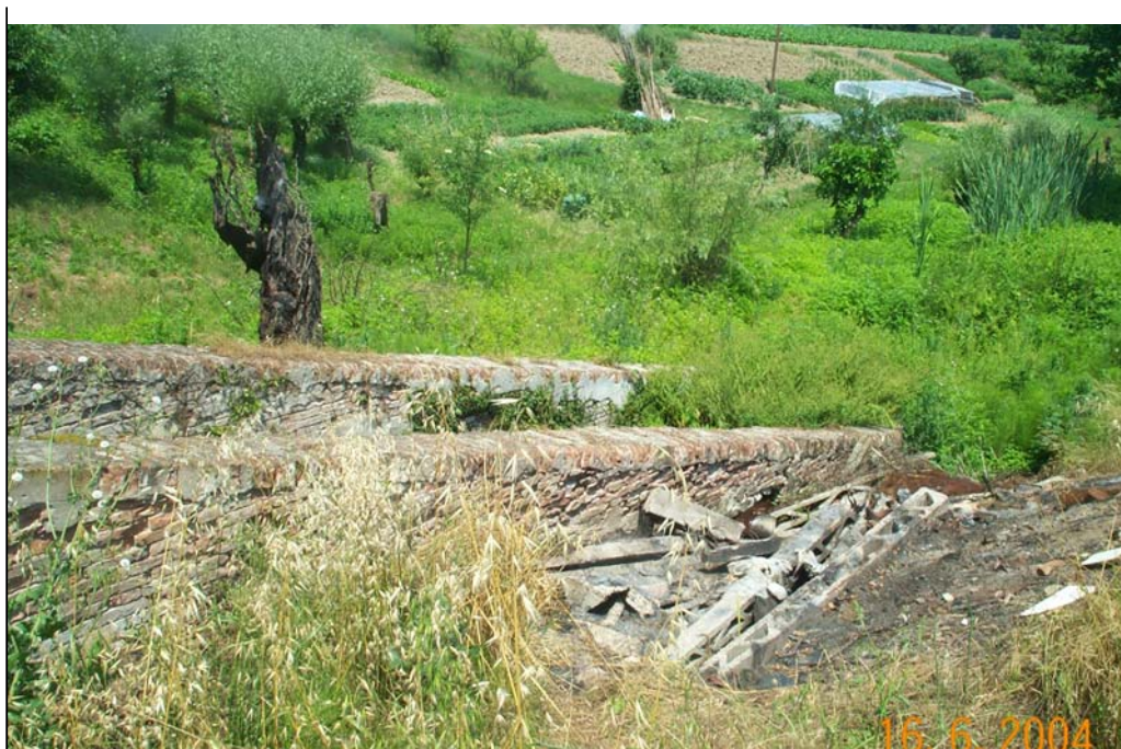
foto n. 15 – La briglia di mattoni che regolamentava il flusso dell'antica segheria; a valle il Canale si apre sull'area di orti privati e campi coltivati
