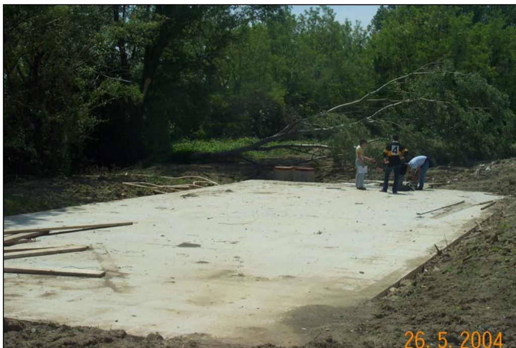
foto n. 17 - La vasca di prima pioggia - disoleatore/desabbiatore delle acque bianche provenienti dalle aree recentemente impermeabilizzate per i parcheggi dell'Outlet e degli ampliamenti della zona industriale del Comune di Castel Guelfo
