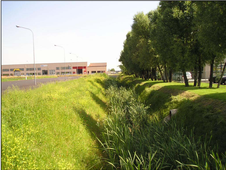
foto n. 53 – Vista del canale di laminazione della Ca' bianca lungo la principale strada di lottizzazione
