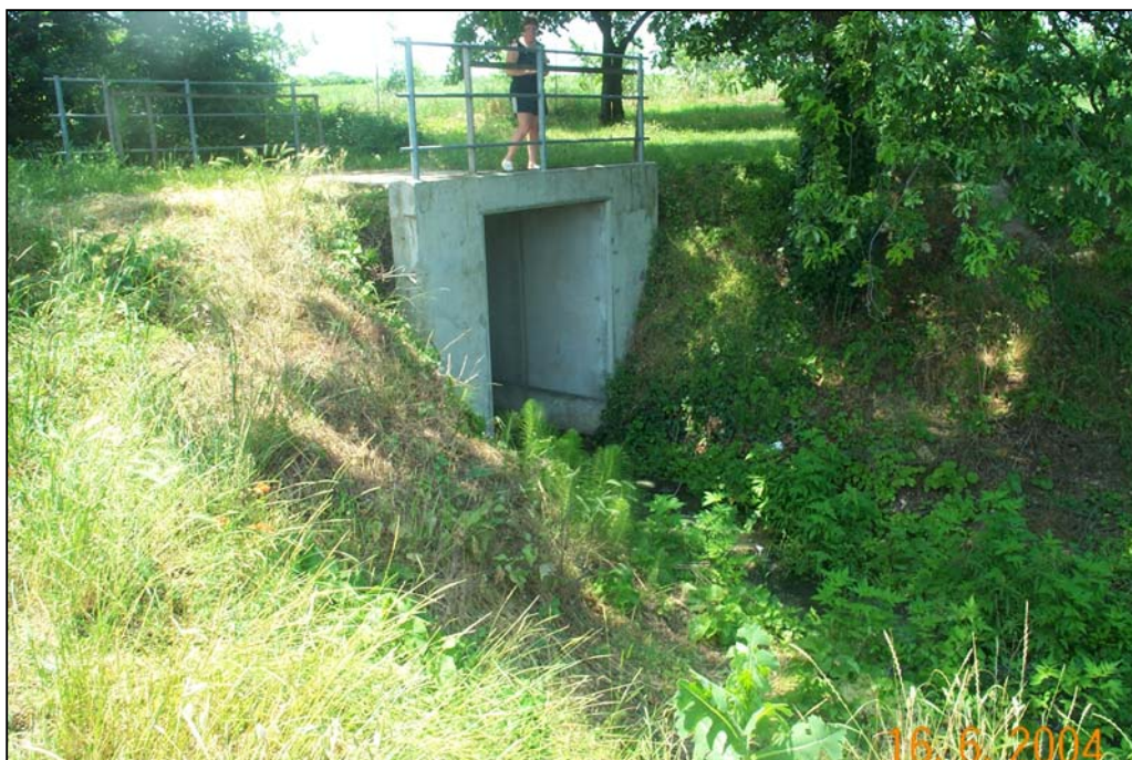
foto n. 14 - Il ponte scatolare in corrispondenza dell'angolo retto.
