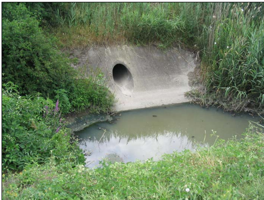
foto n. 34- Uno scarico di acque bianche a nord di Medicina in corrispondenza di un nucleo residenziale
