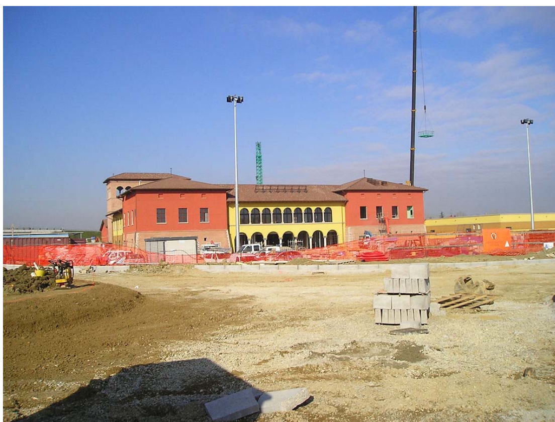
Foto 4 L' "Outlet" in fase di costruzione
