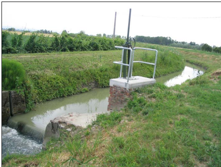
foto n. 40 - tratto del canale con argini alti: si noti anche qui la presenza di una briglia con travata
