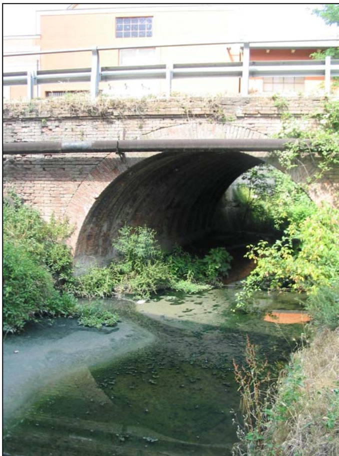
foto n. 33 – L'attraversamento del Canale di Medicina del ponte sulla San Vitale
