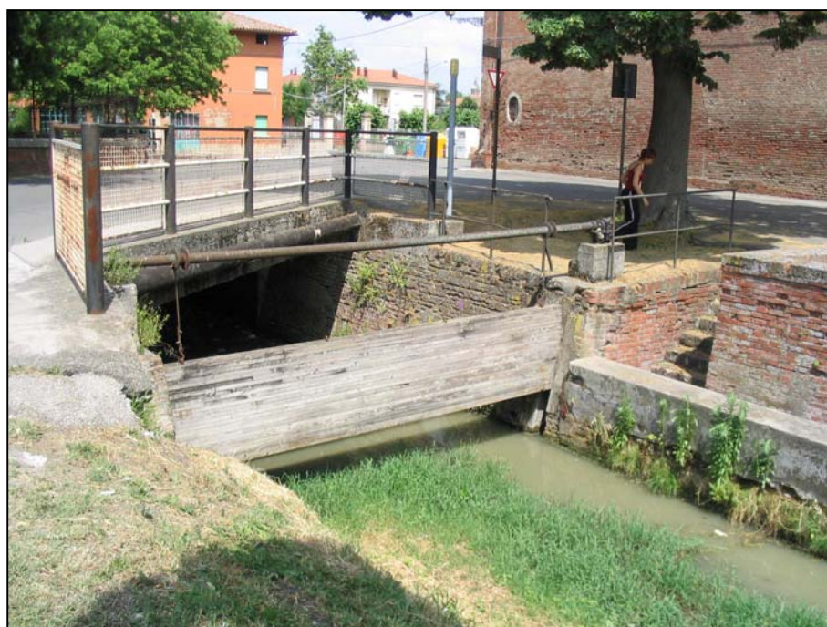
foto n. 30 – L'ingresso del Canale nel tombamento di centro storico: si veda la travata e il meccanismo di azionamento
