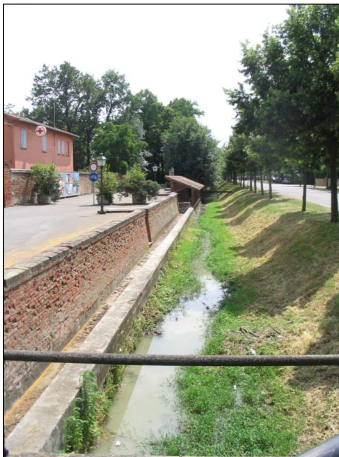
foto n. 29 – Il Canale in corrispondenza del Lavatoio comunale di Medicina
