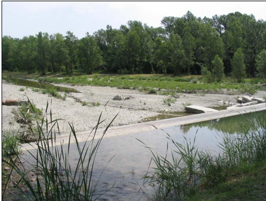
foto n. 1 – La travata sul Torrente Sillaro in corrispondenza della Chiusa
