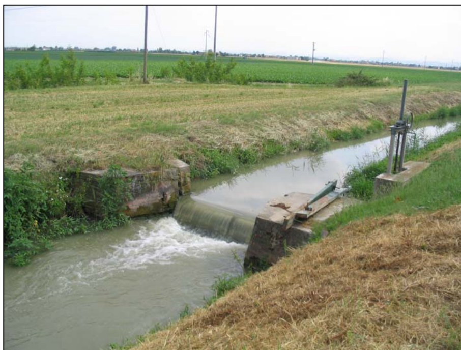
foto n. 39 - una briglia in Cemento posta in corrispondenza di un'altra derivazione
