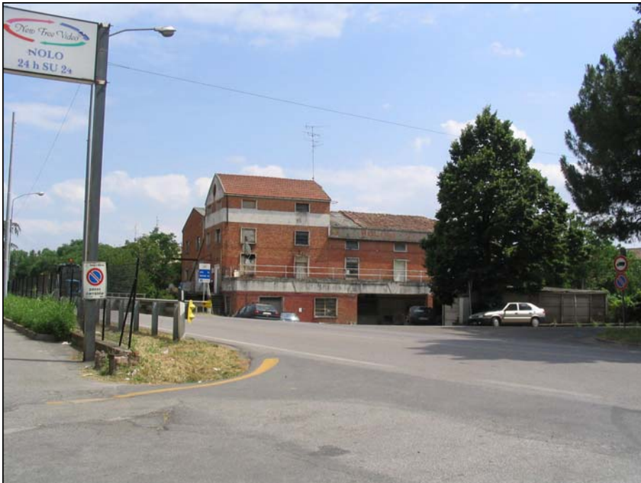
foto n. 32 – Il Mulino Vecchio visto dalla Strada provinciale San Vitale
