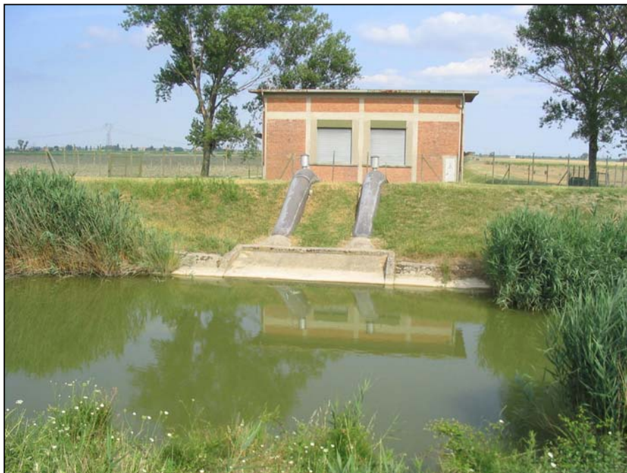
foto n. 44 – Un'idrovora di Via del Merlo in gestione della Bonifica Renana
