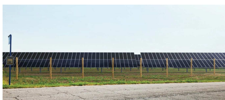
Figura 3. Recinzione di un impianto fotovoltaico con pali in legno e rete metallica in alluminio.
