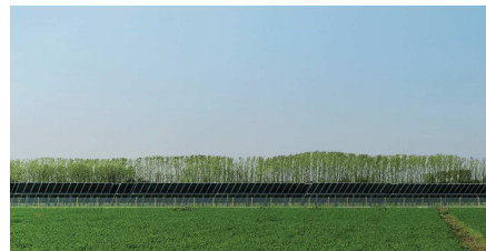
Figura 4.a impianto fotovoltaico recintato con in pali in legno e rete metallica.
