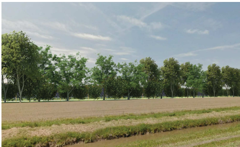
Figura 9. Impianto fotovoltaico schermato da una fascia multispecifica arborea-arbustiva..
