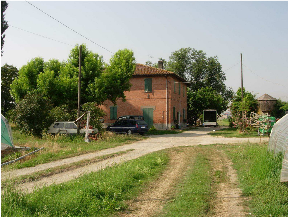
Abitazione e Silos
