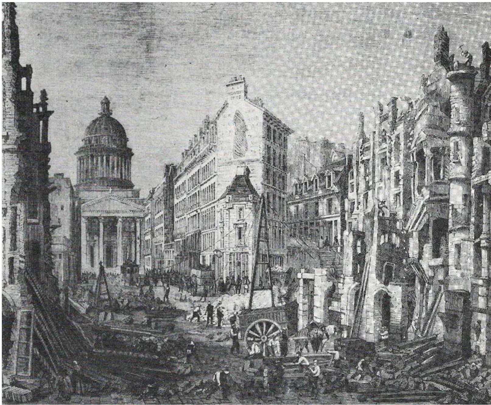
Parigi, demolizioni Housmanniane
