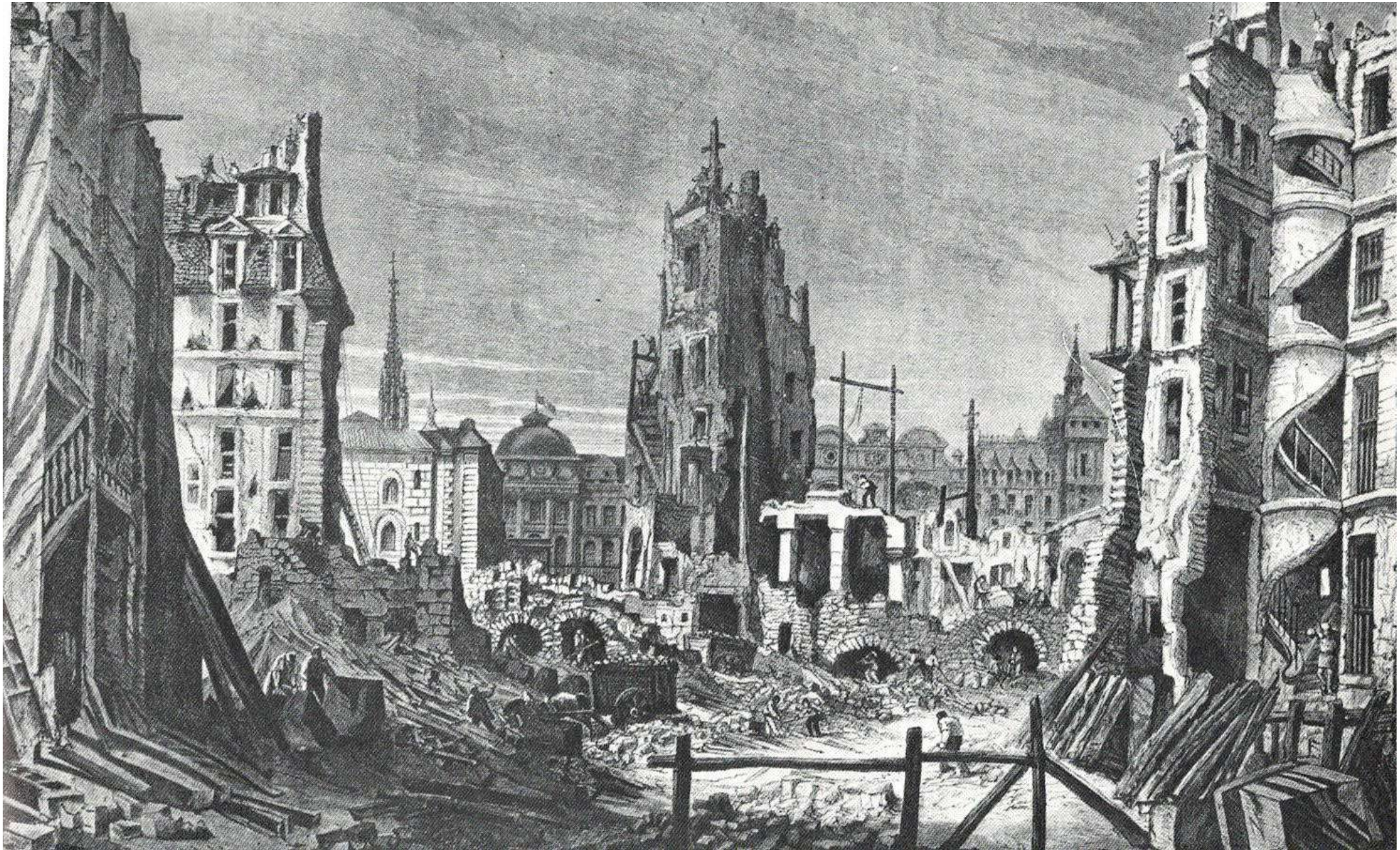
Parigi, demolizioni Housmanniane
