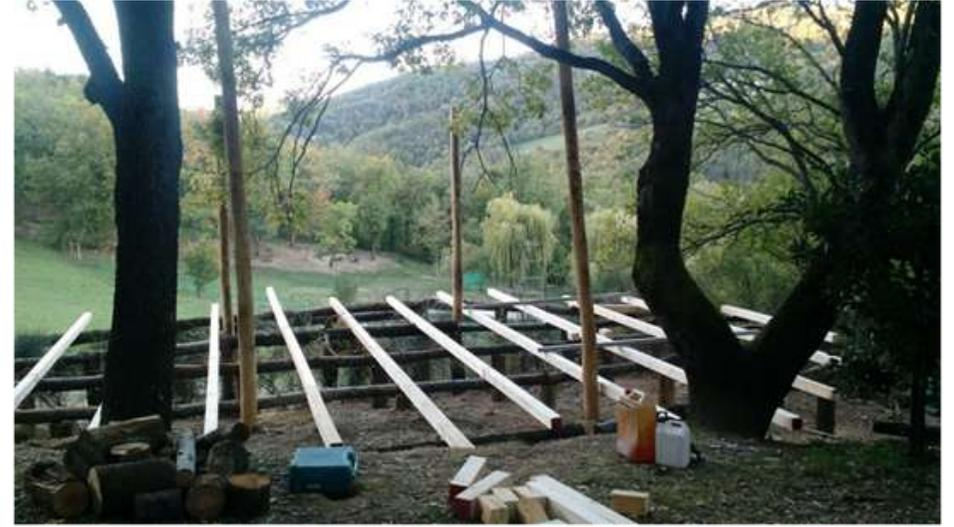
Livellamento delle travi di fondazione con travetti in abete 10x10 posti ogni 80 cm, a volte spessorati, a volte si è reso necessario intagliare la parte superiore della trave in castagno.
