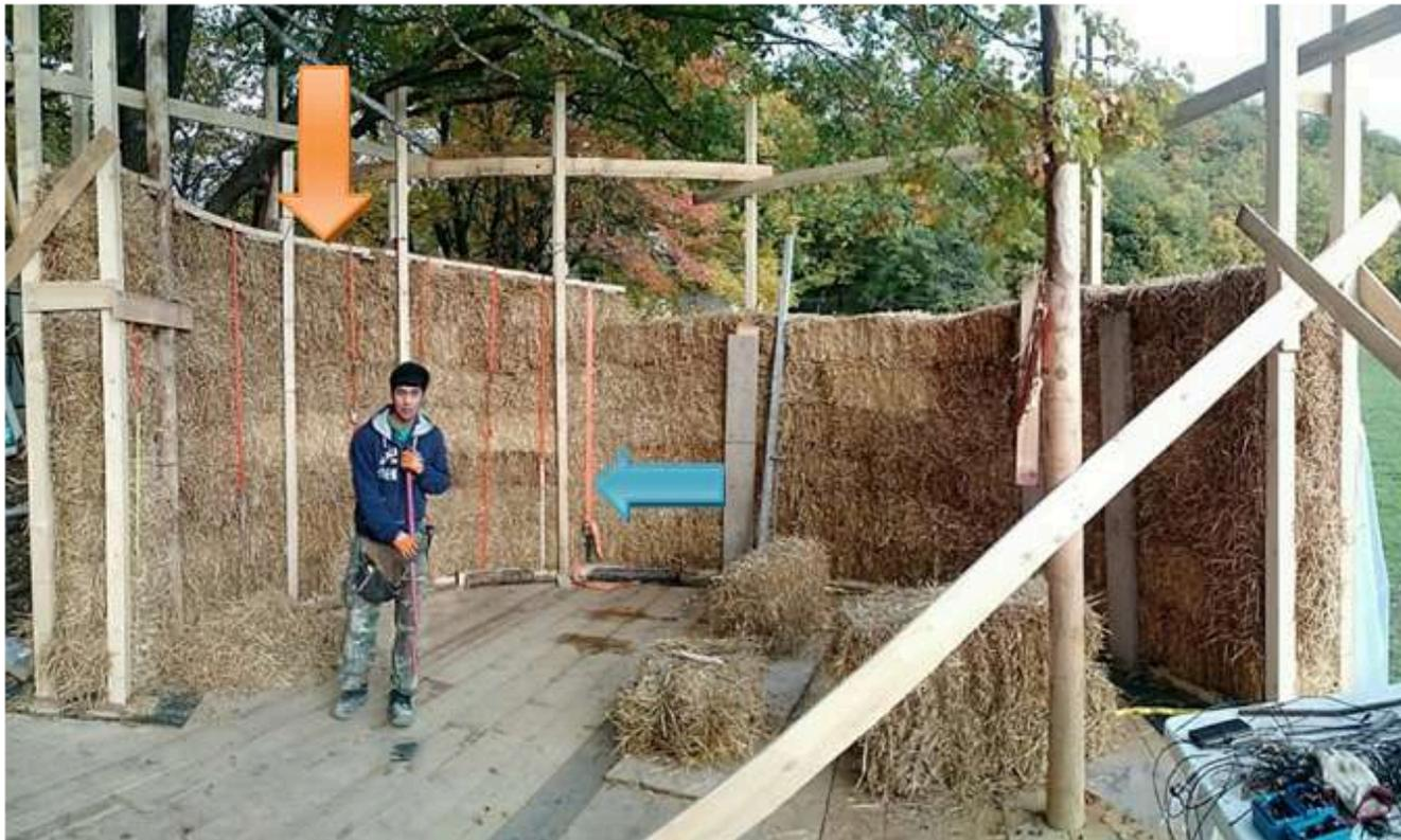
A sinistra il muro finito e compresso, a destra l'impostazione sopra alla centina inferiore (freccia arancione)
