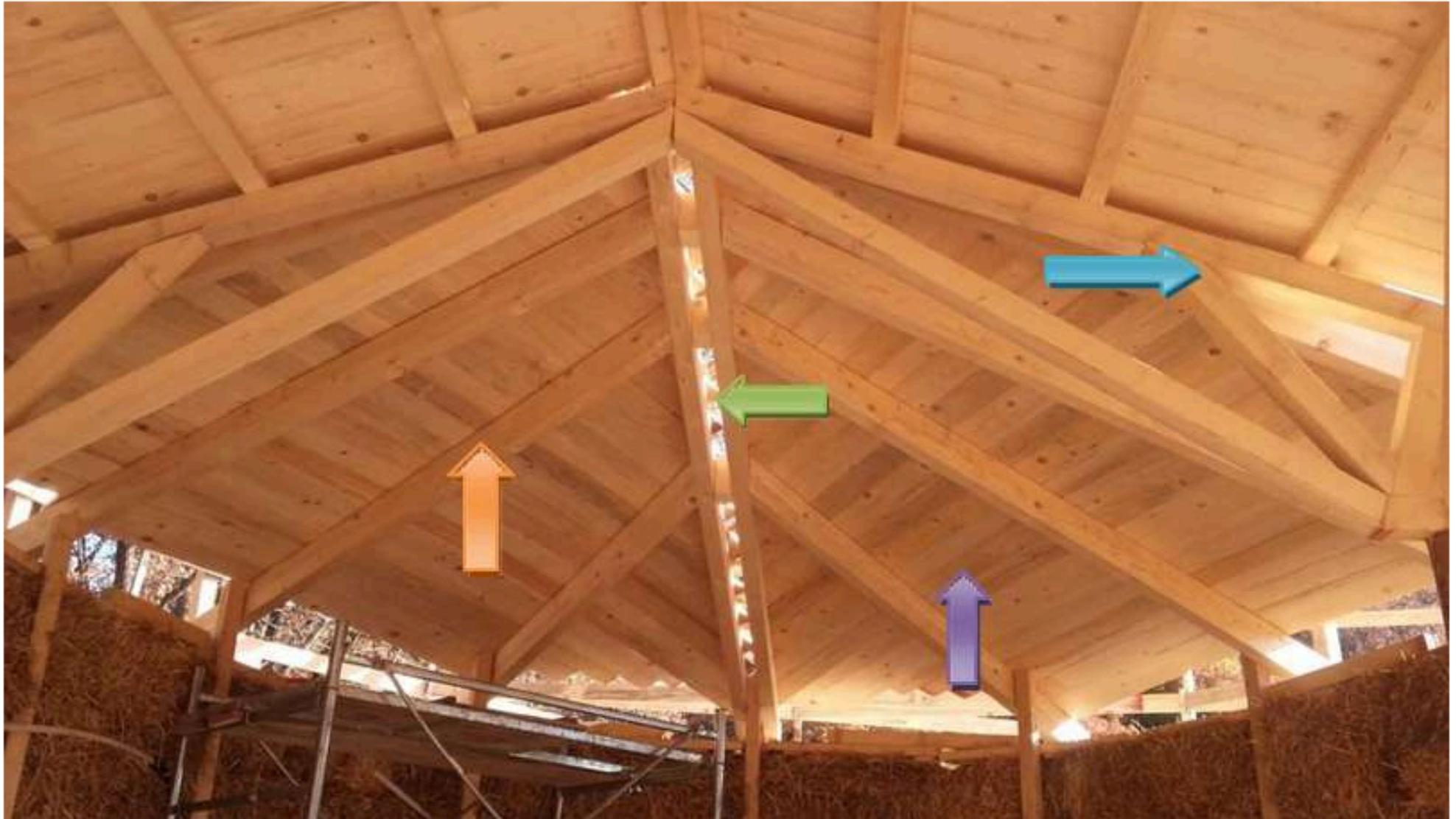
Capriata (freccia blu), trave centrale (freccia verde), travetti di seconda orditura (freccia arancione) e primo impalcato (freccia viola), il tavolato del primo impalcato è curvato in modo da sovrapporsi al tavolato del corpo centrale.
