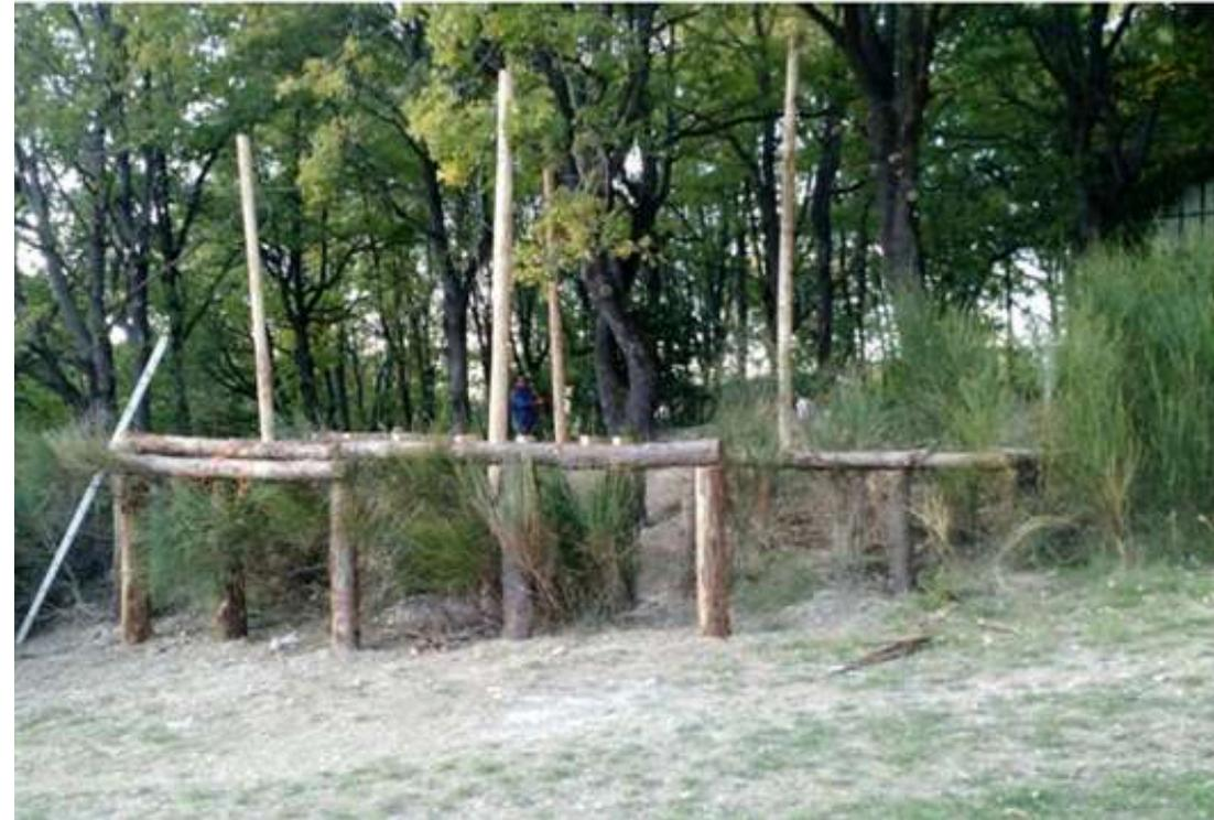
Collegamento dei pali di fondazione con travi in castagno grezze. I pali sono conficcati per circa 50 cm e stretti a mano nella sede di scavo con pietrisco e terra, tutta l'operazione è stata fatta senza l'ausilio di mezzi meccanici.
