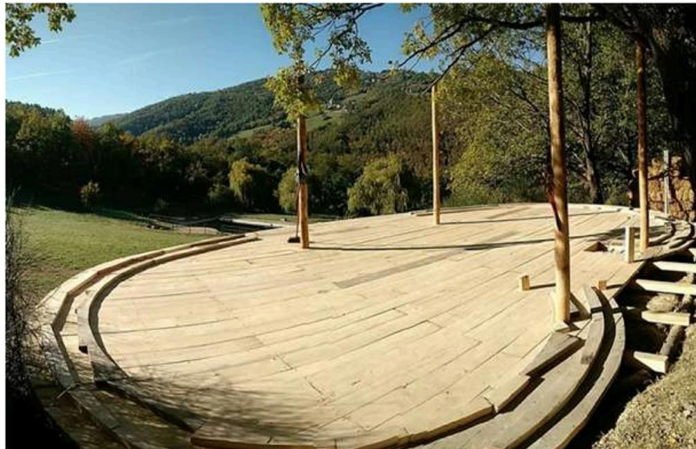
Primo impalcato e tracciamento del muro in balle di paglia, i 4 pali in castagno che sveltano sopra l'impalcato saranno i pilastri di sostegno delle due capriate costruite in opera.
