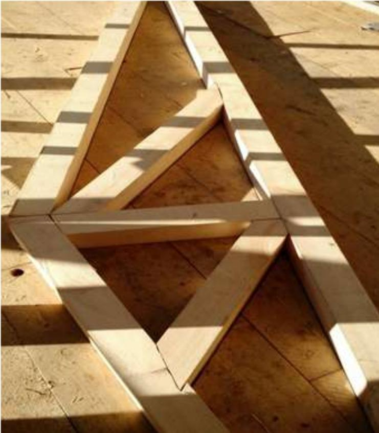
Tracciamento in loco di una delle due capriate, taglio ed assemblaggio della stessa. Visti i pesi ridotti è stato possibile montare questo elemento strutturale senza l'ausilio di mezzi come gru o autogru.
