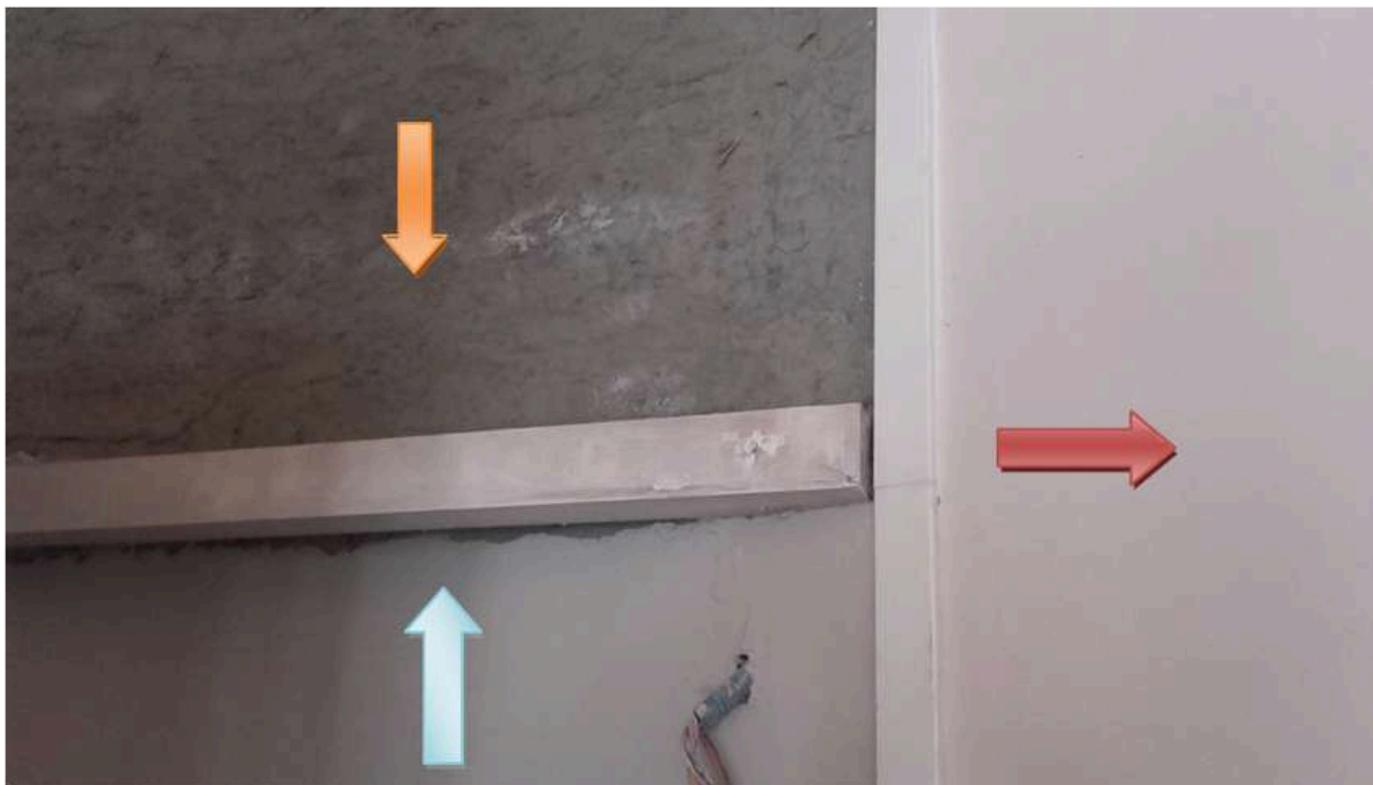
Secondo strato, intonaco di corpo (freccia arancione), finitura di sola argilla (freccia azzurra) e ultima finitura, (argilla colorata con ossidi). Il periodo stagionale in cui si eseguono i lavori e conseguentemente i tempi di asciugatura giocano un ruolo importante.
