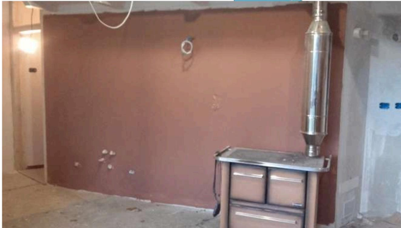
L'acqua, riscaldata dai fumi della combustione, entra nel circuito a parete, super coibentato dalle balle di paglia e protetto da uno strato di terra cruda di circa 7 cm, che fungerà da piastra di irraggiamento. La stessa acqua calda passerà dentro il boiler di raccolta per l'acqua calda sanitaria.
