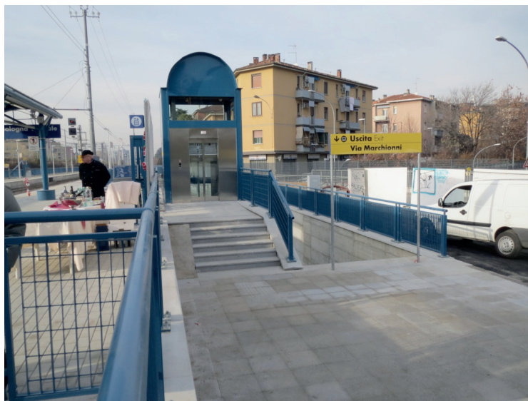
UN ASCENSORE DELLA NUOVA STAZIONE BOLOGNA S. VITALE SULLA LINEA FERROVIARIA PER RIMINI
