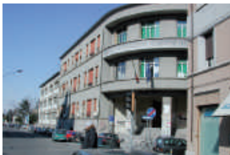
Liceo A. Righi - Veduta esterna via Tolmino
