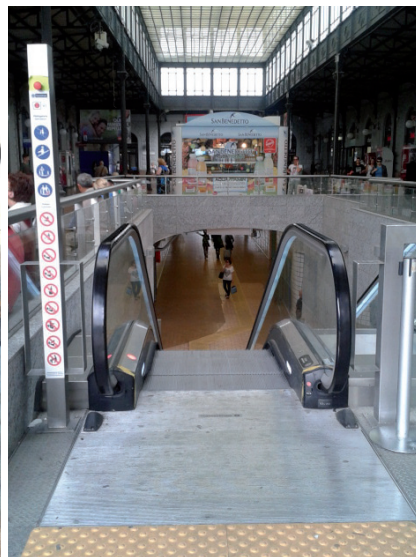
NUOVE SCALE MOBILI DEL PIAZZALE OVEST DELLA STAZIONE CENTRALE DI BOLOGNA
