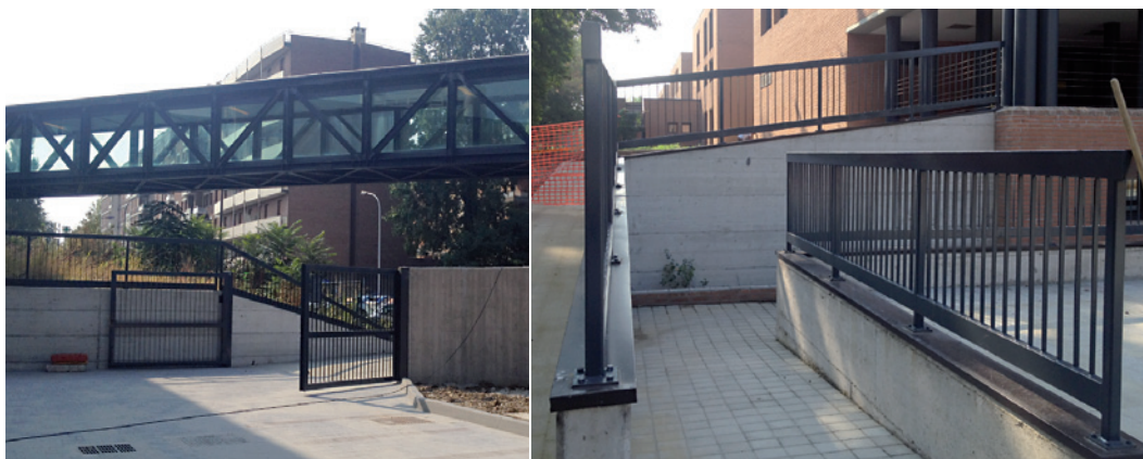
LICEO COPERNICO - INGRESSO AREA PARCHEGGIO E RAMPA DISABILI
