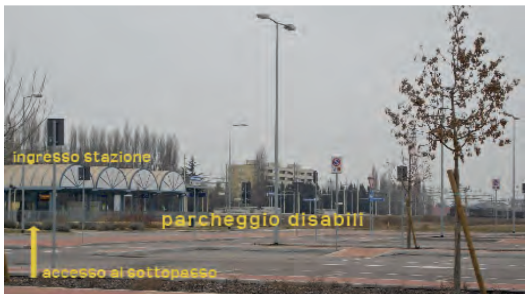
PARCHEGGI PER DISABILI NELLA STAZIONE FERROVIARIA DI CASTEL MAGGIORE SI NOTI LA VICINANZA CON L'ACCESSO AL SOTTOPASSAGGIO PASSANTE
