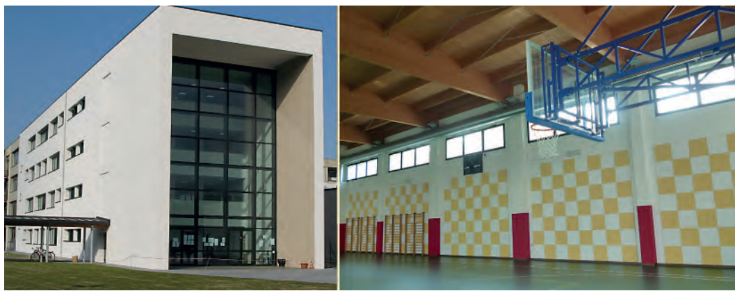
I.I.S. "E. MATTEI" IN S.LAZZARO DI SAVENA (VIA DELLE RIMEMBRANZE, 26), FACCIATA AMPLIAMENTO E NUOVO ASCENSORE
