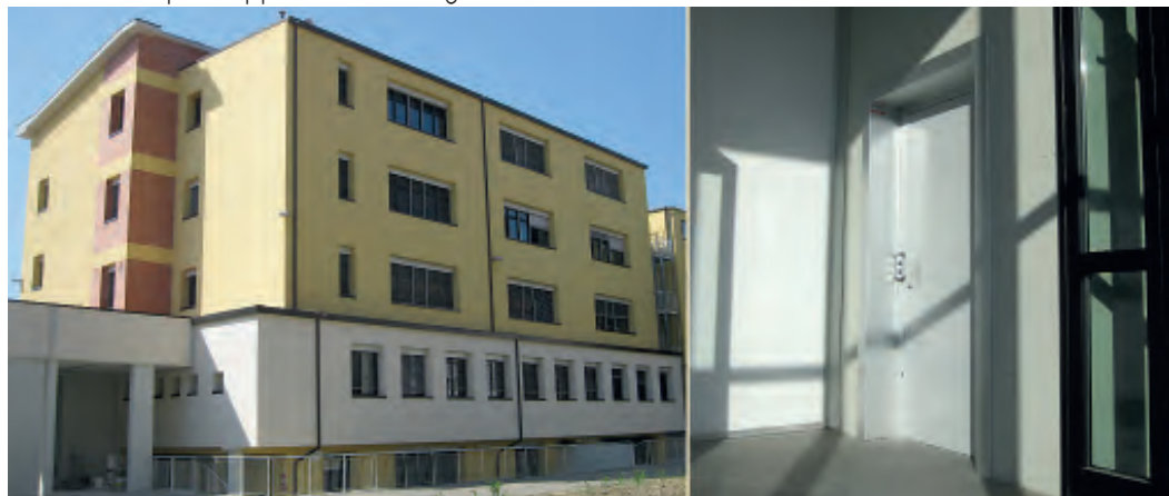
LICEO SCIENTIFICO "A.B. SABIN" IN BOLOGNA (VIA MATTEOTTI 7), FACCIATA AMPLIAMENTO E NUOVO ELEVATORE
