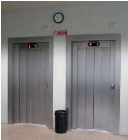
Nuovi ascensori - foto d'insieme
