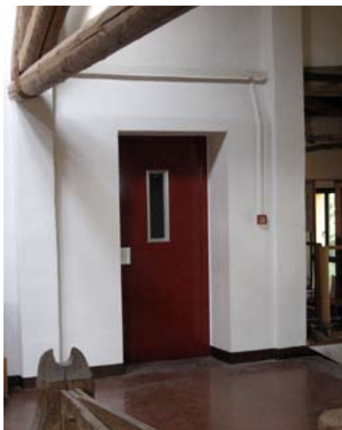
particolare sbarco della piattaforma al primo piano
