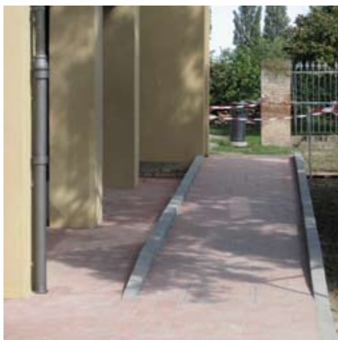
Particolare della rampa d'accesso di ingresso
