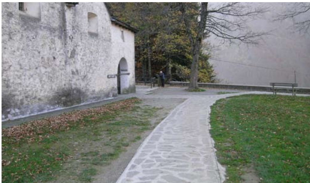
Area di Madonna dell'Acero. Il percorso di accesso in lastre di arenaria porta dalla strada provinciale alla piazzola di sosta panoramica.
