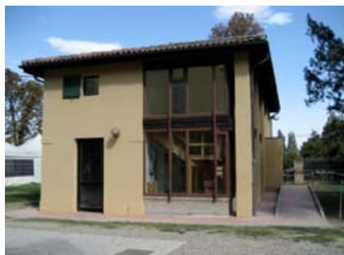
Aula didattica - rampa di accesso
