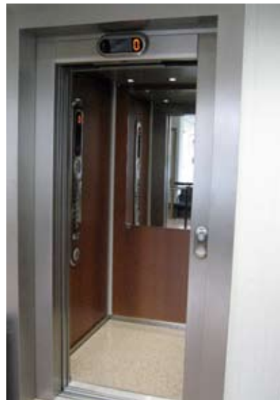
particolare interno dell'ascensore
