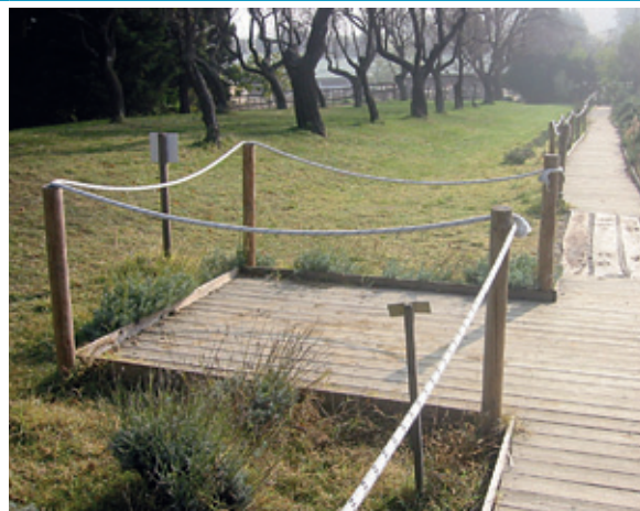
DULCAMARA. TRATTO DEL PERCORSO. IN CORRISPONDENZA DEI CARTELLI ESPLICATIVI LA PAVIMENTAZIONE CAMBIA. LO SLARGO PERMETTE DI EFFETTUARE UNA SOSTA LUNGO IL PERCORSO PER RIPOSARSI E GODERSI LA VISTA SUI CAMPI ADIACENTI.
