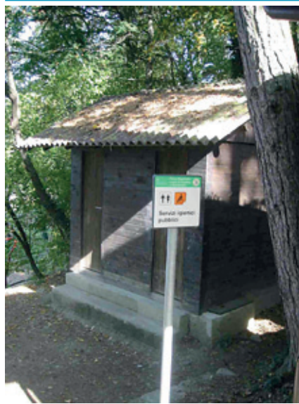
SERVIZIO IGIENICO ACCESSIBILE AI DISABILI
