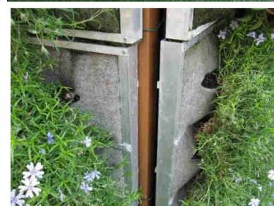
Esempio di barriera verde autoportante con moduli e tasche atte a contenere substrato e differenti specie erbacee a portamento ricadente.
