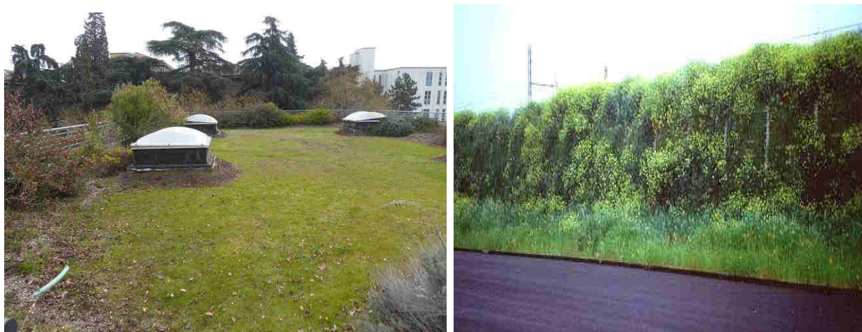
A sinistra: copertura a verde estensivo su capannone di servizio. A destra, esempio di barriera verde a lato di sede ferroviaria con copertura erbacea e arbustiva.
